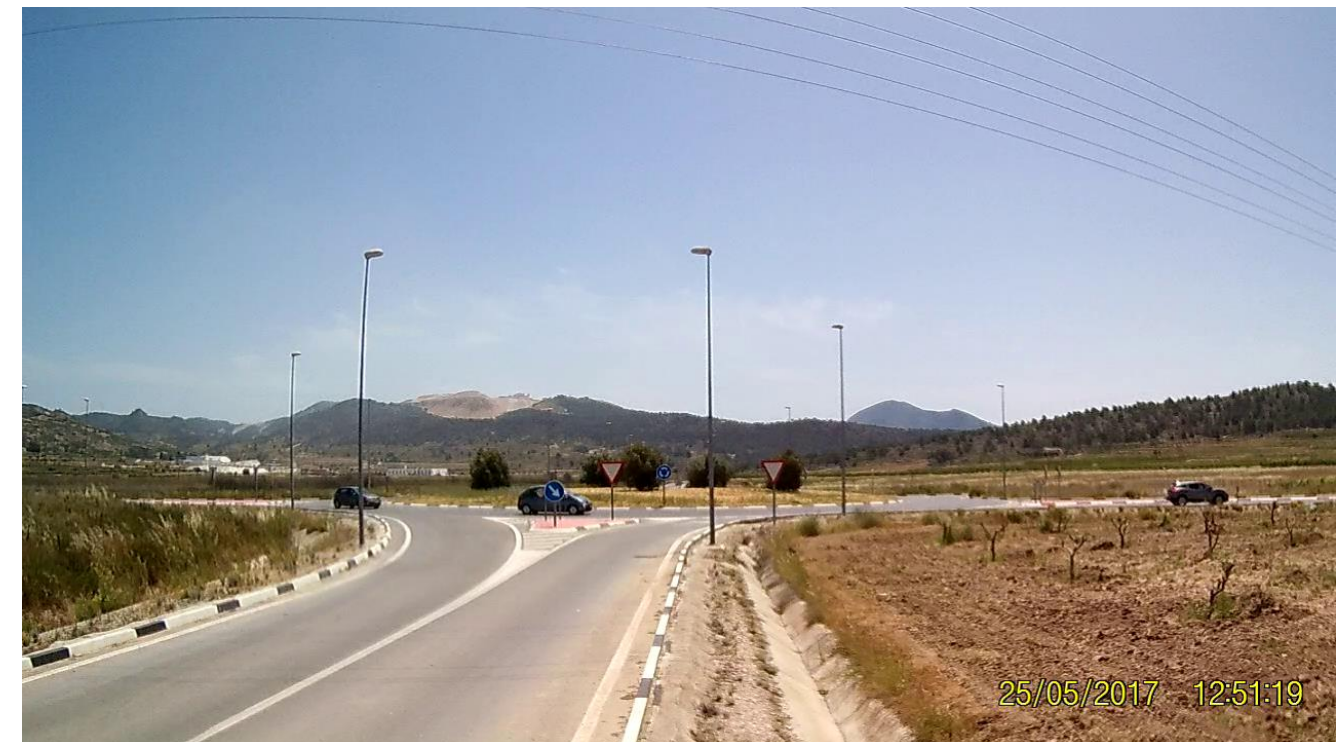
Ilustración 30. Punto de aforo P. 02. Vista de la glorieta desde el ramal 3, acceso a la población El Rodriguillo.
