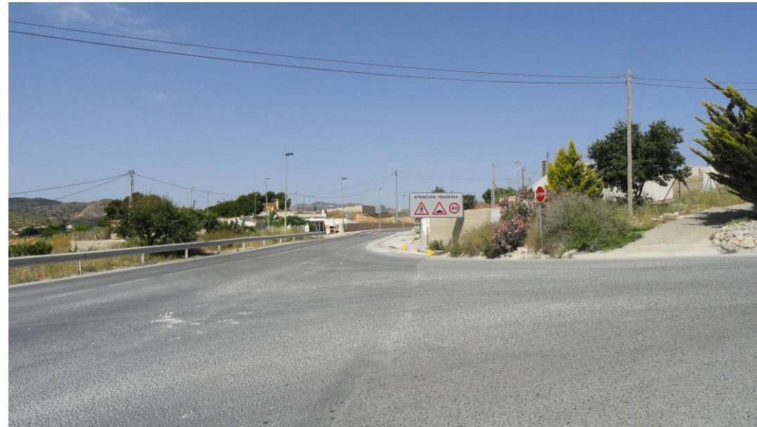
Ilustración 12. Acceso a Monte Coto desde la carretera CV-840, sentido Algueña.
