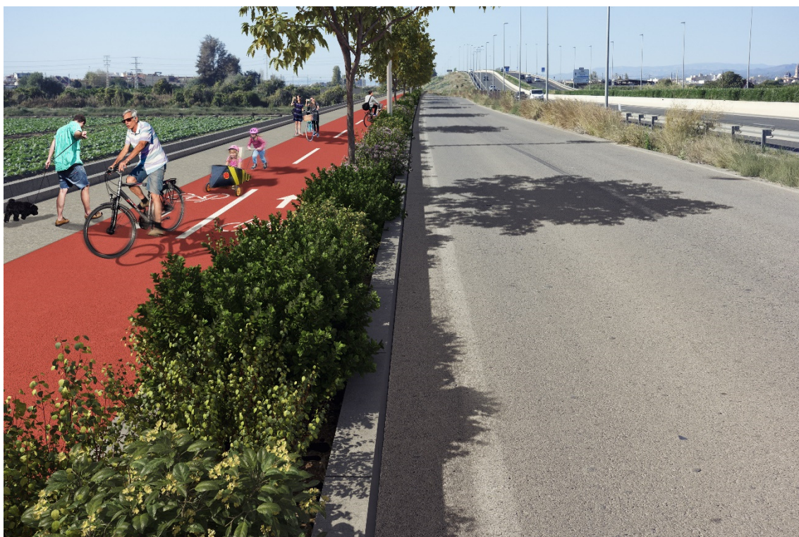
Infraestructura ciclo-peatonal a la via de servei de la CV-32
