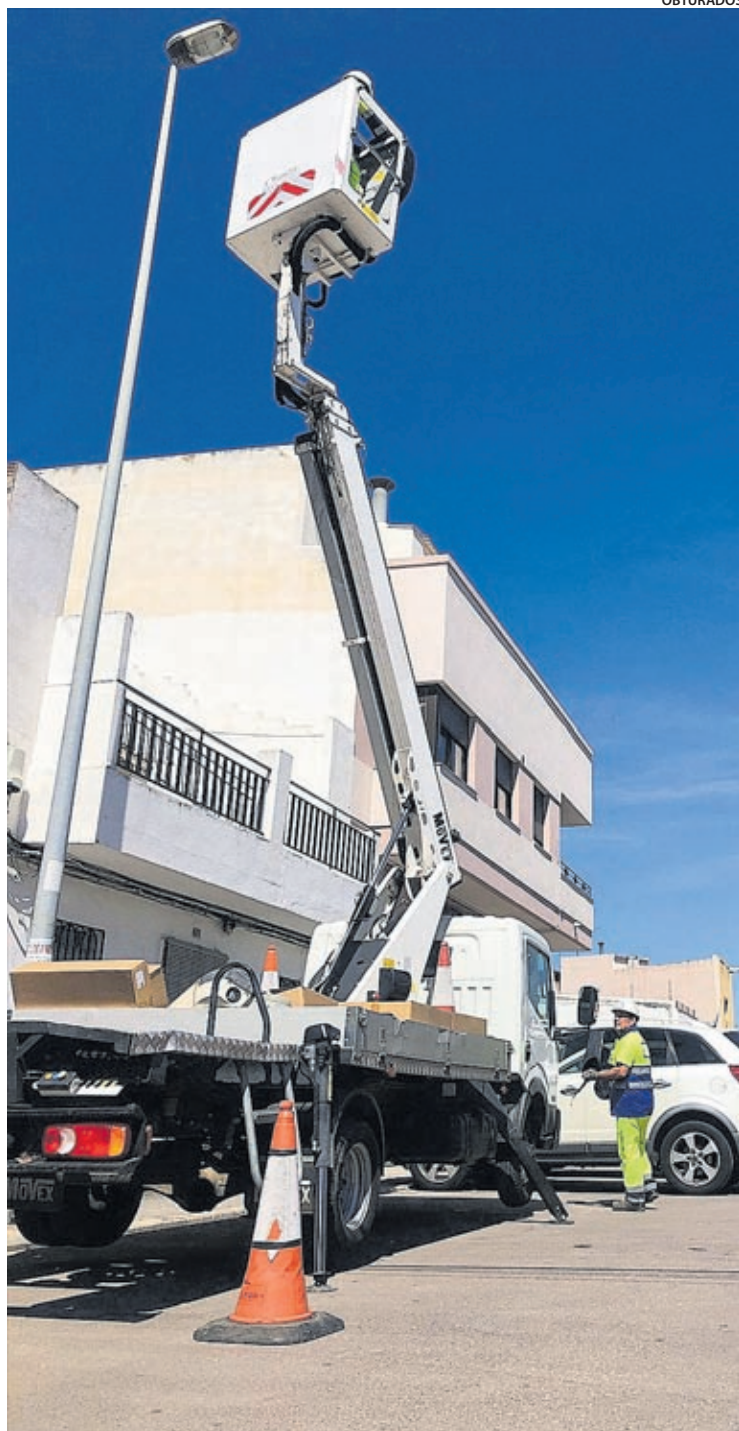
El objetivo de estas acciones es renovar la instalación de alumbrado público.
