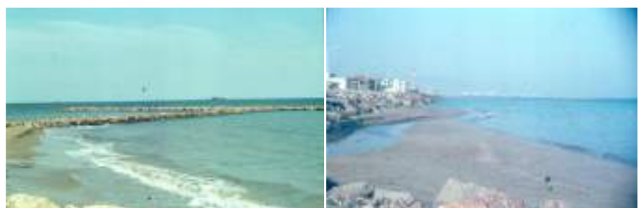
Figura 9. Dique exento norte
