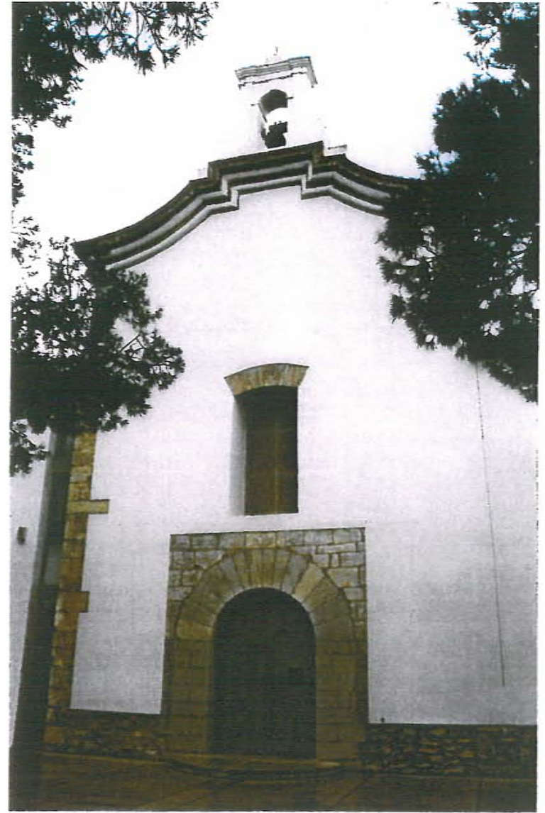
Alzado principal antes de la intervención.
