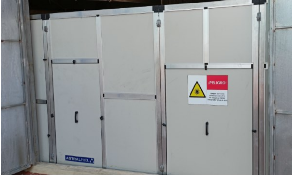
Ejecución de la obra 2
