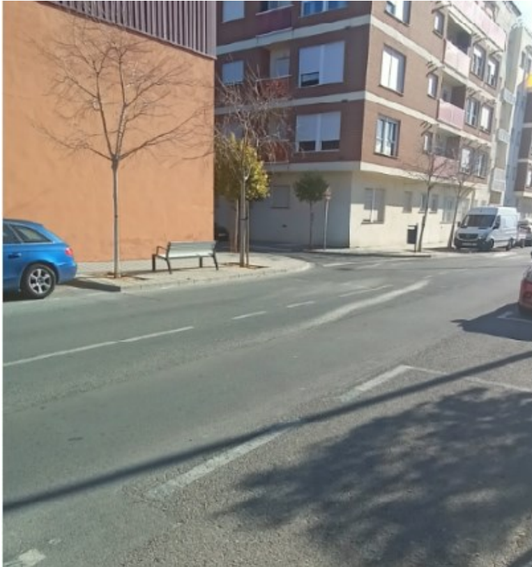
Ejecución de la obra 2
