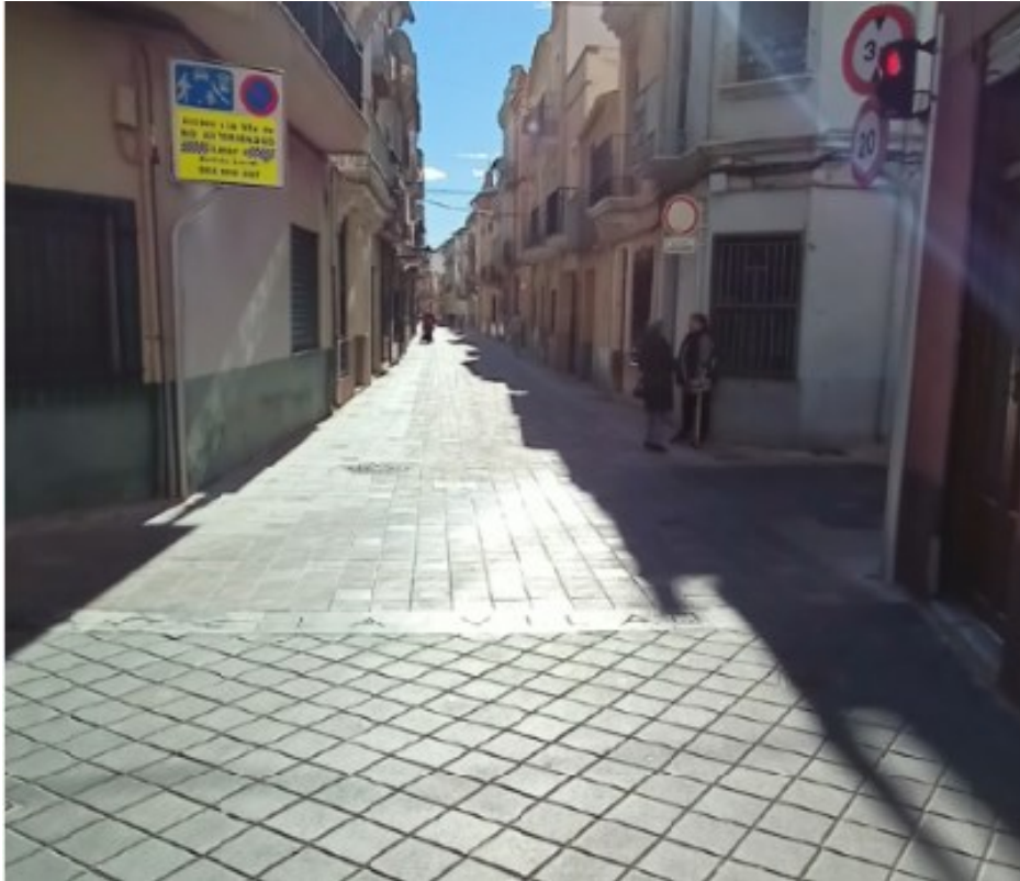
Ejecución de la obra 3
