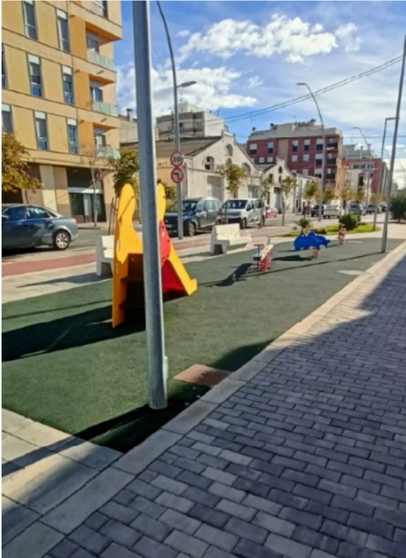
Ejecución de la obra 4
