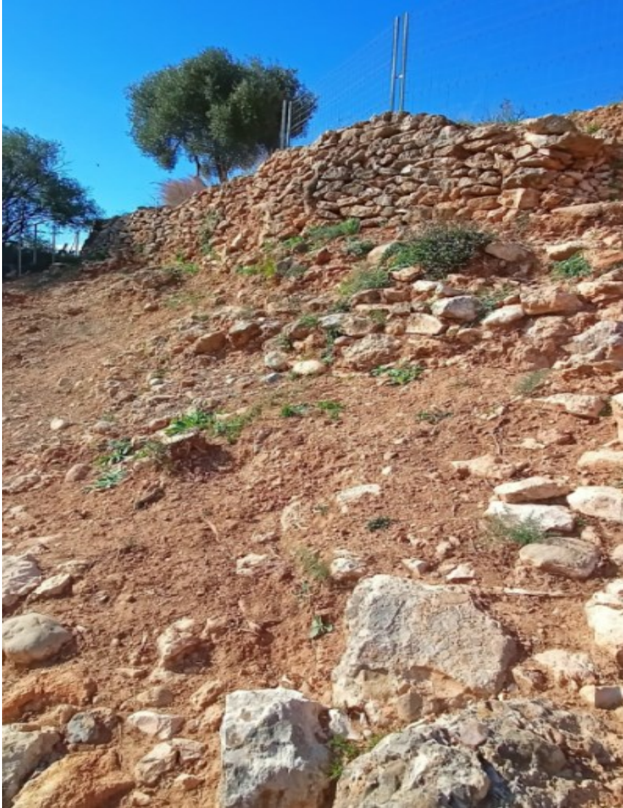
Ejecución de la obra 3
