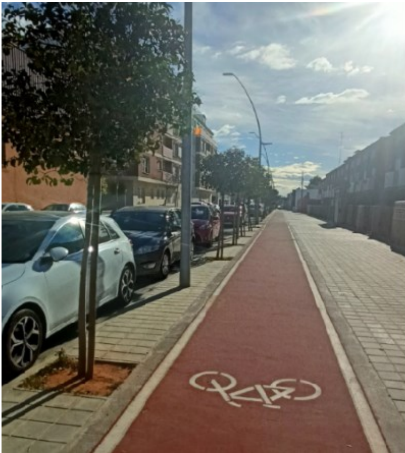
Ejecución de la obra 1
