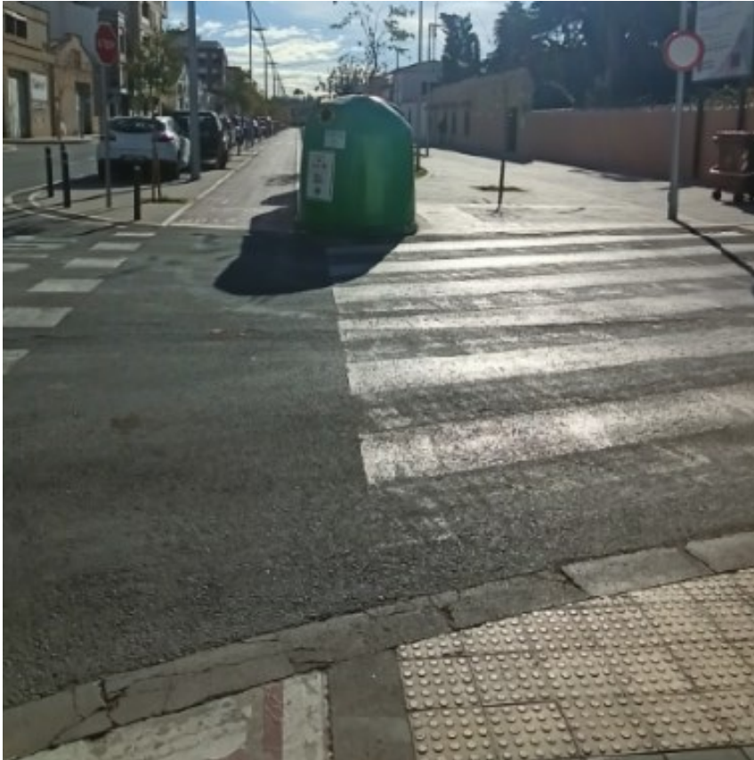
Ejecución de la obra 5
