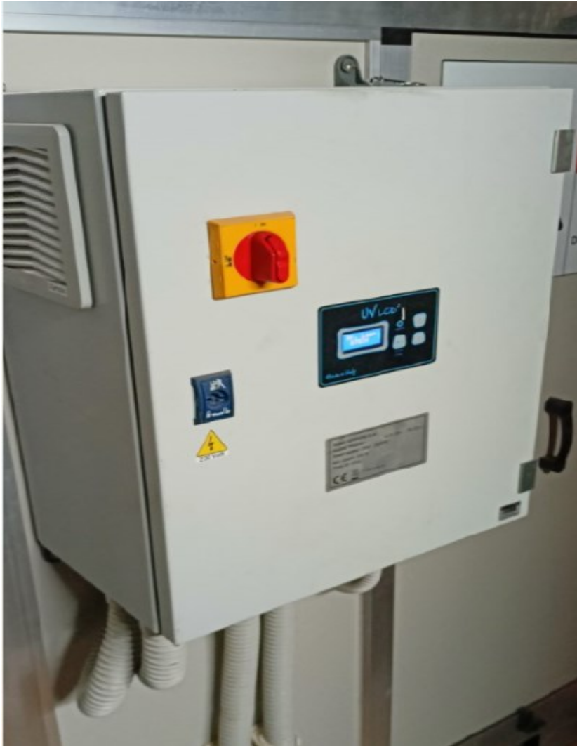
Ejecución de la obra 3
