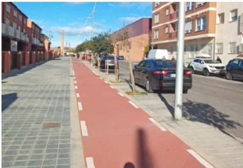
Ejecución de la obra 3
