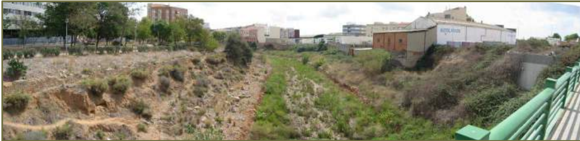
Vista del tramo del Riu Sec, con cauce natural, en su entrada a Castellón bordeando la Universidad Jaime I, previo a su encauzamiento
