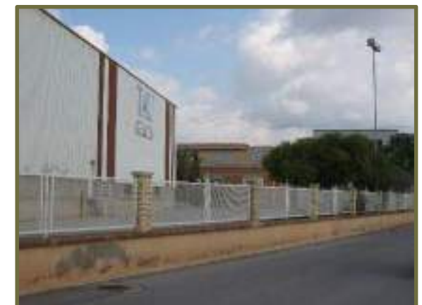
Naves industriales al lado de viviendas
