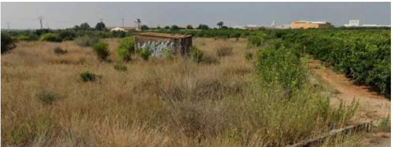
Fotografía nº 8. Caseta de riego en el interior de la parcela
