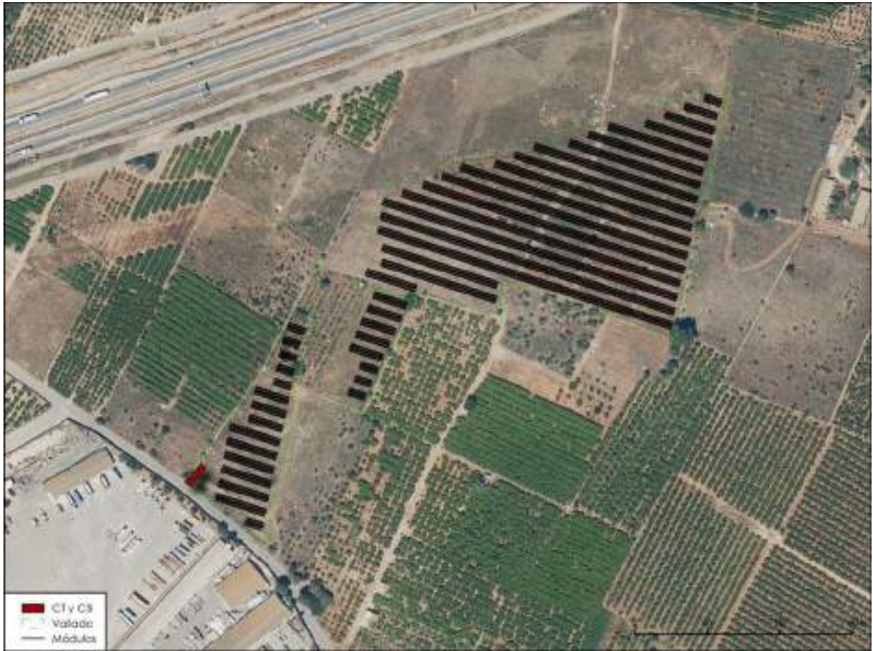
Figura 1.- Distribución de la planta
