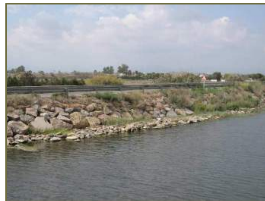
Encauzamiento artificial de tipo naturalizado en el Riu Sec.
