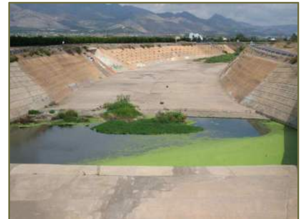
Salida del encauzamiento del Riu Sec por la parte este del Casco Urbano. La vista dura del cauce contrasta con el aspecto naturalizado que ofrece en los siguientes tramos hasta su desembocadura.
