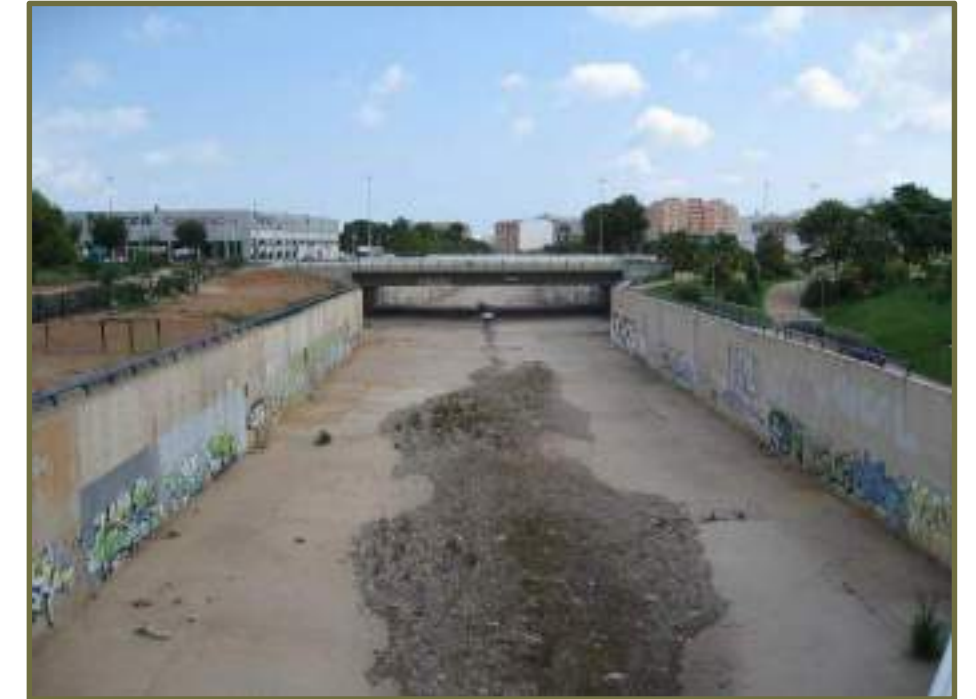
Tramo inicial previo al encauzamiento subterráneo del Riu Sec a su paso por el casco urbano de Castellón. La vista dura del cauce contrasta con el aspecto naturalizado que ofrece en los tramos anteriores a su encauzamiento en la parte oeste del término.
