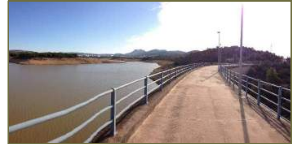
Imagen tomada desde el puente de la Presa de María Cristina con el embalse hacia la izquierda de la fotografía y la Rambla de la Viuda hacia la derecha de la imagen
