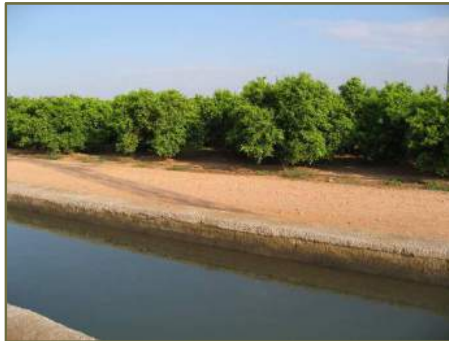
Infraestructura hidráulica. Contrucción del canal de la cota 100
