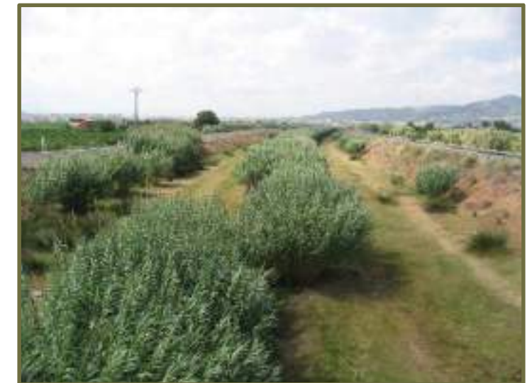
Riu Sec en una vista tomada en dirección a la ciudad de Castellón. El cauce es naturalizado en este tramo y se aprecia la vegetación asociada de tipo fluvial.
