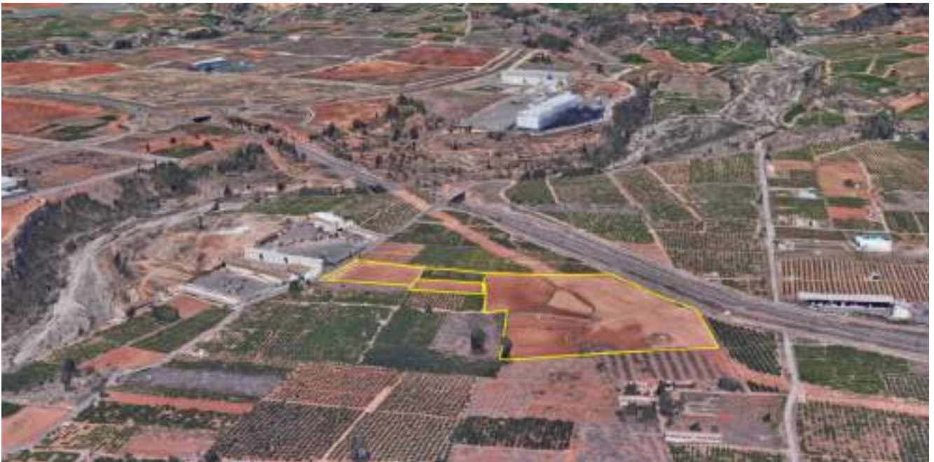
Figura 11.- Zona altamente degradada y ocupada por actividades industriales
