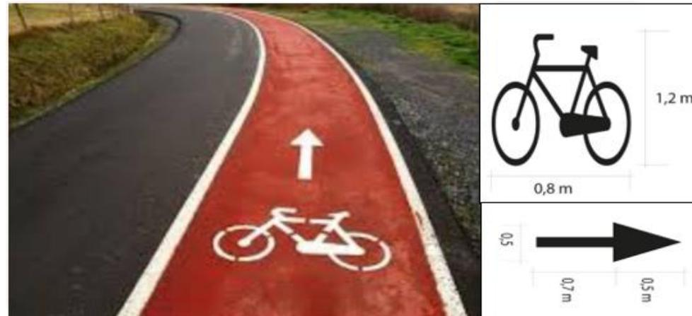
Imagen 20-3.9 Ejemplo de señalización horizontal de carril bici segregado.
