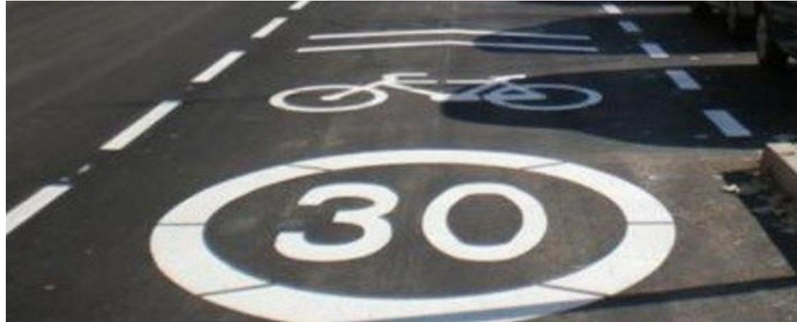
**Imagen 20-3.8 Ejemplo de señalización horizontal de una ciclo-calle.**
