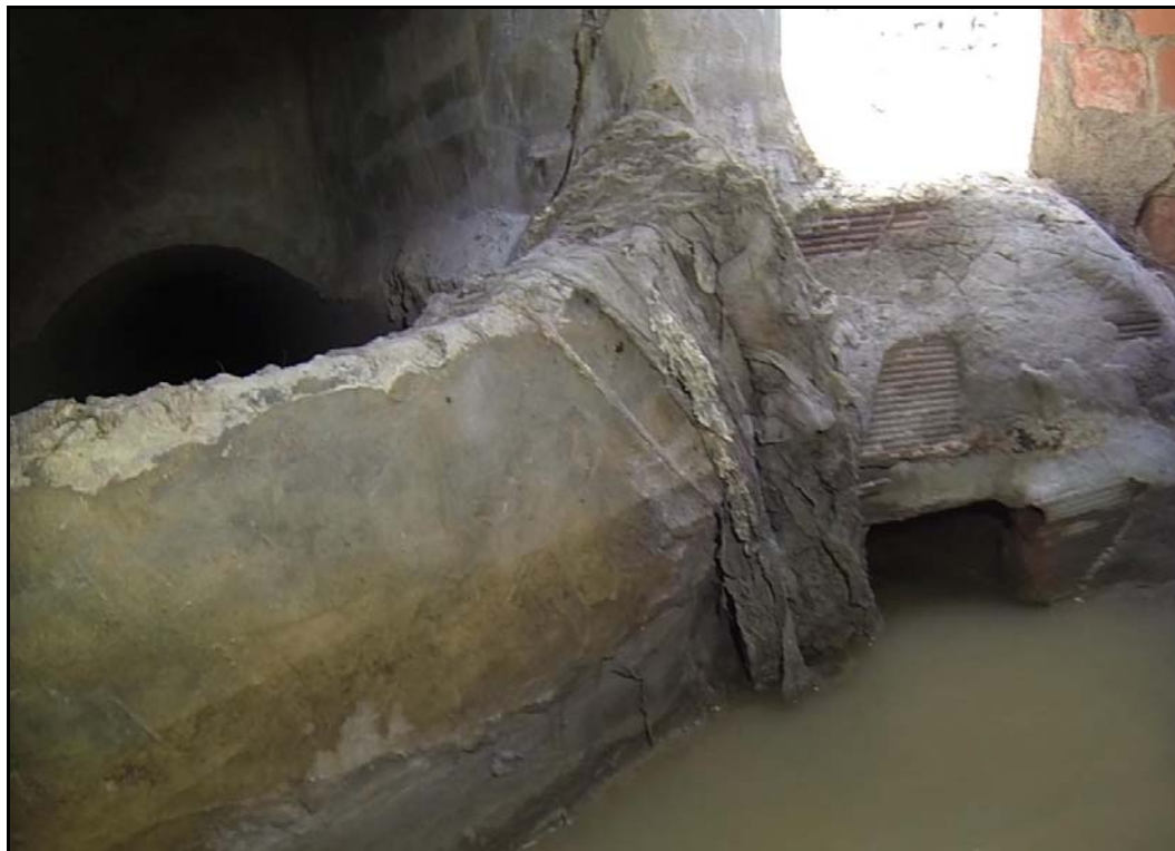
Aliviadero y orificio existente
