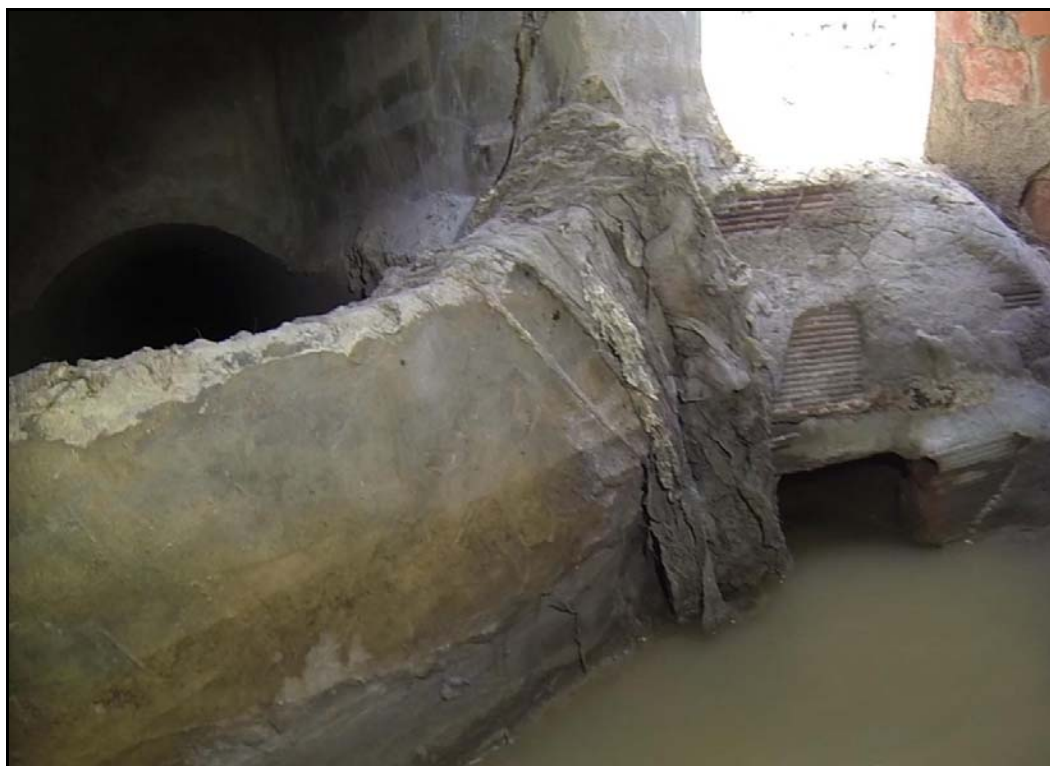
Aliviadero y orificio existente
