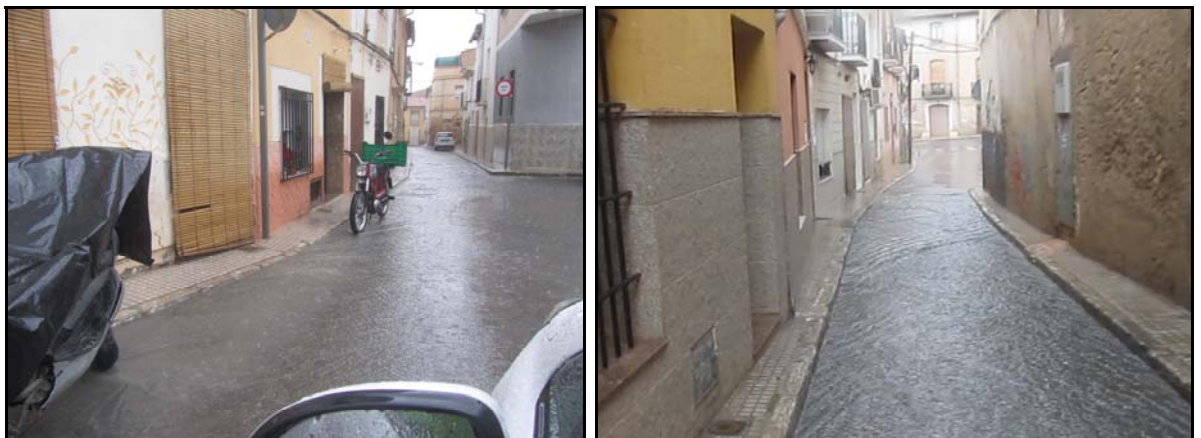
Escorrentía superficial C/ San Pascual
