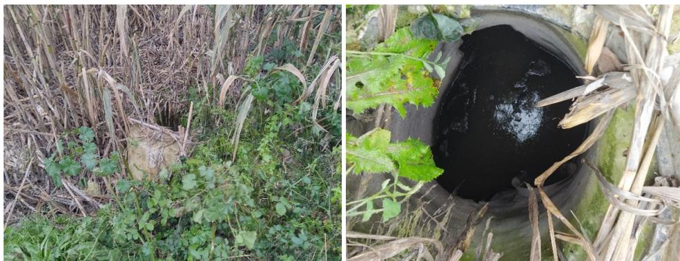
Figura 6. Tramo en gravedad previo a la estación de bombeo, lugar poco accesible, con acumulación prolongada de aguas residuales y mala protección del pozo, que se encuentra abierto.
