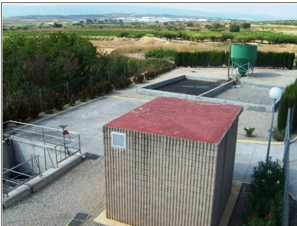
Figura 31. EDAR de Benissuera. Fuente: EPSAR
