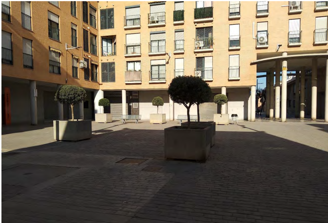
Plaça del Poble. Vista parcial en la que se observa que el modelo de banco instalado no es accesible
