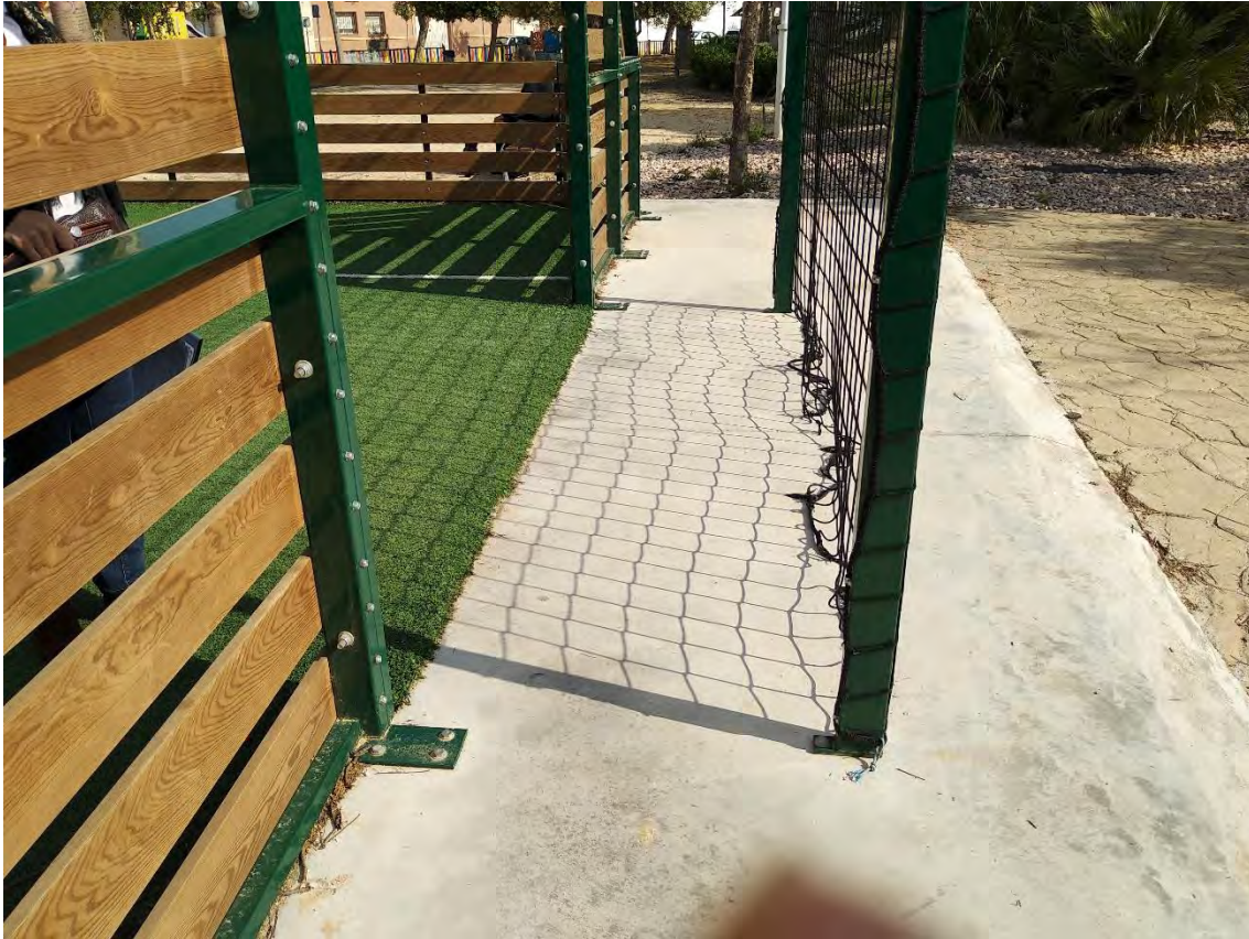
C/ Ernest Lluch Martí. Anchura insuficiente para acceder a la pista multideporte.
