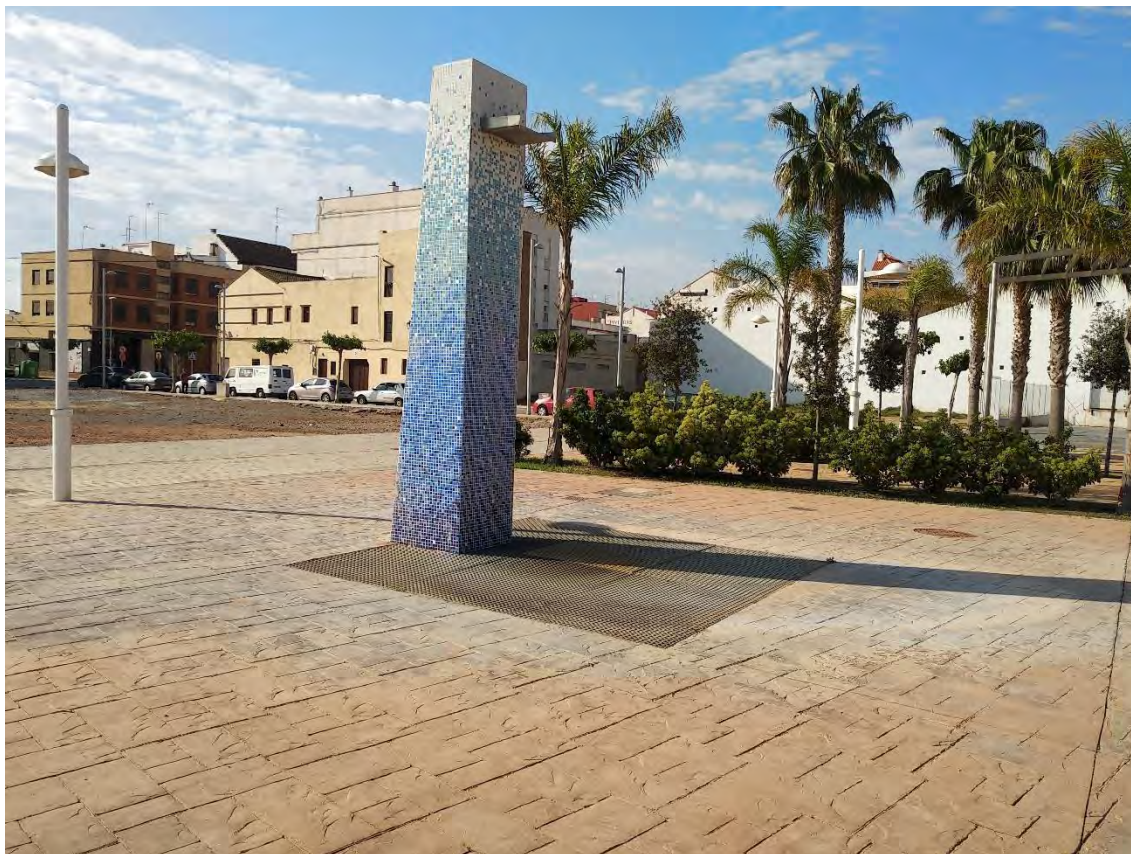
C/ Ernest Lluch Martí. La falta de señalización táctil del enrejillado puede provocar que personas ciegas invadan la zona de caída de agua de la fuente.
