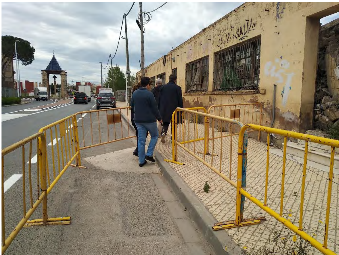
Antigua Carretera de Barcelona. Itinerario alternativo por peligro en fachada antiguo cuartel.
