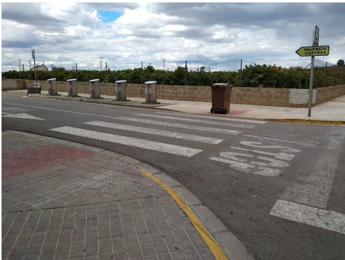
C/ Verge del Pilar, 43. Contenedor ubicado en el centro del vado peatonal.
