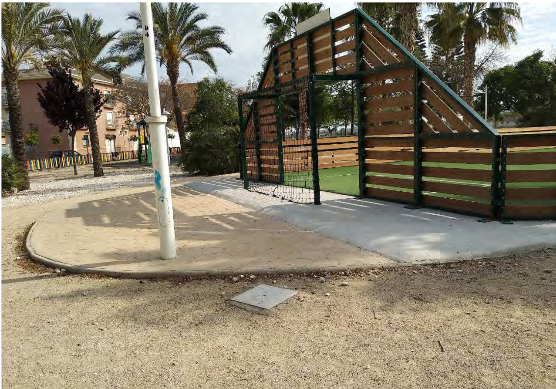
C/ Ernest Lluch Martí. No hay punto de entrada accesible al perímetro de la zona deportiva, que presenta un bordillo.
