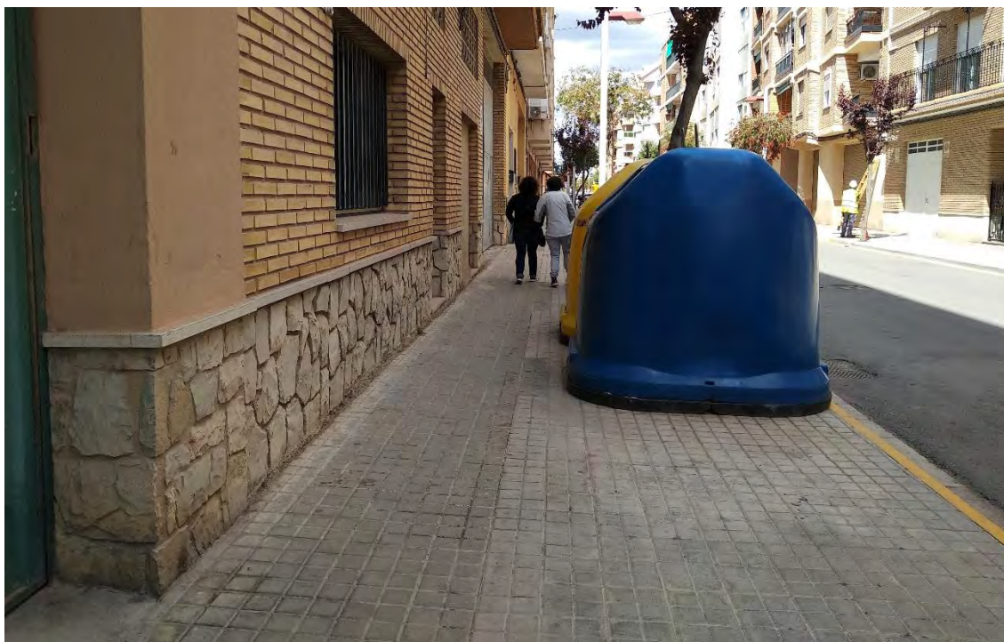
C/ Pintor Vicente Lluch. Estrechamiento del itinerario peatonal por ubicación de contenedores.
