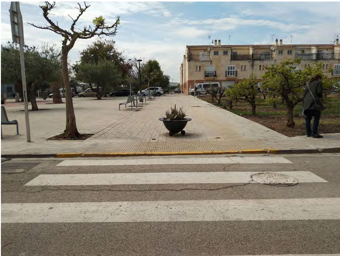
C/ Del Mig. Paso de peatones sin vado y con obstáculo en el centro del itinerario.
