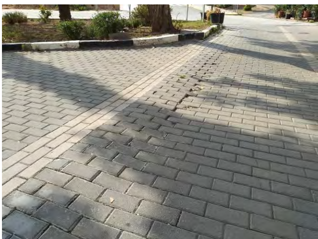
Plaza del Sol: El pavimento presenta zonas levantadas.
