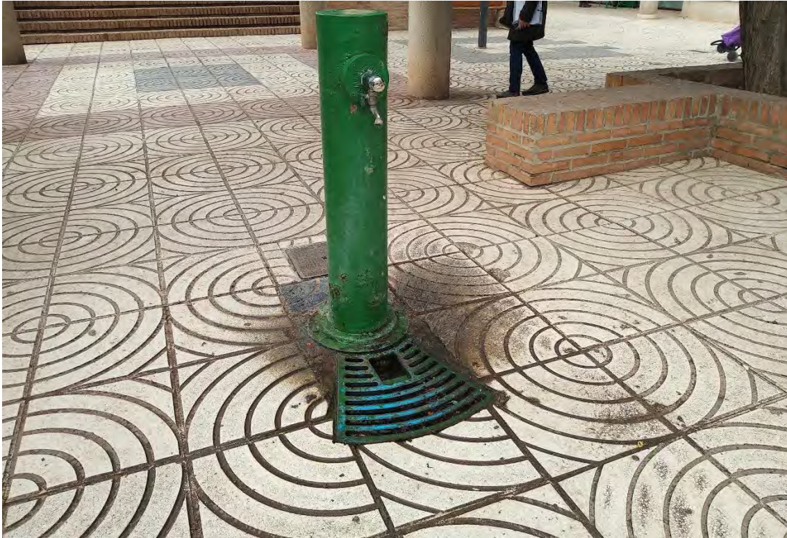
Plaça de la Llar. Fuente accesible en cuanto a ubicación y dimensiones, pero con difícil accionamiento.
