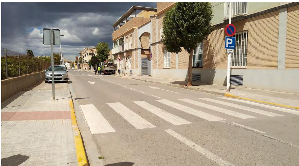
C/ Herbassers. Aparcamiento sobre resalto y discontinuidad de la acera.
