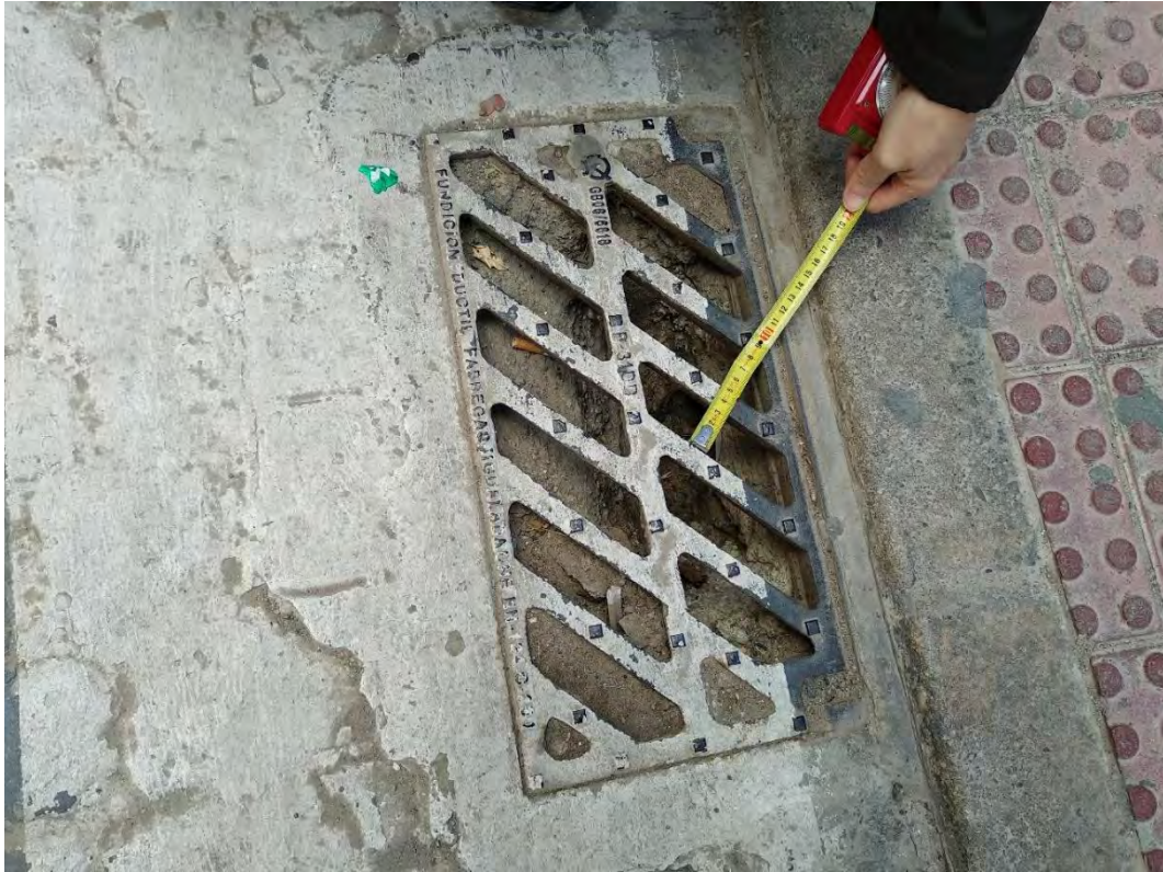
C/ Verge del Pilar, 22. Imbornal dentro de paso peatonal y con abertura superior a \varnothing 2,5 cm
