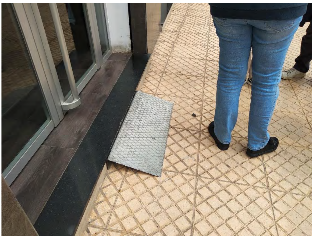
Carretera de Barcelona. La chapa metálica invade la acera.
