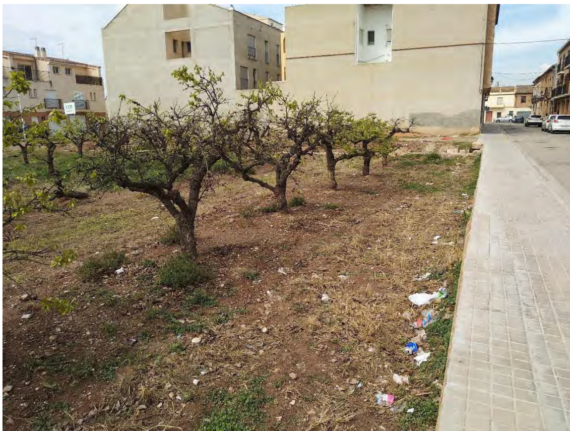
C/ Del Mig. Campo sin vallado que presenta desnivel considerable respecto a la acera.
