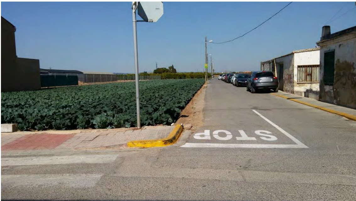
Camí del Cementeri. Coches aparcados estrechando la vía.
