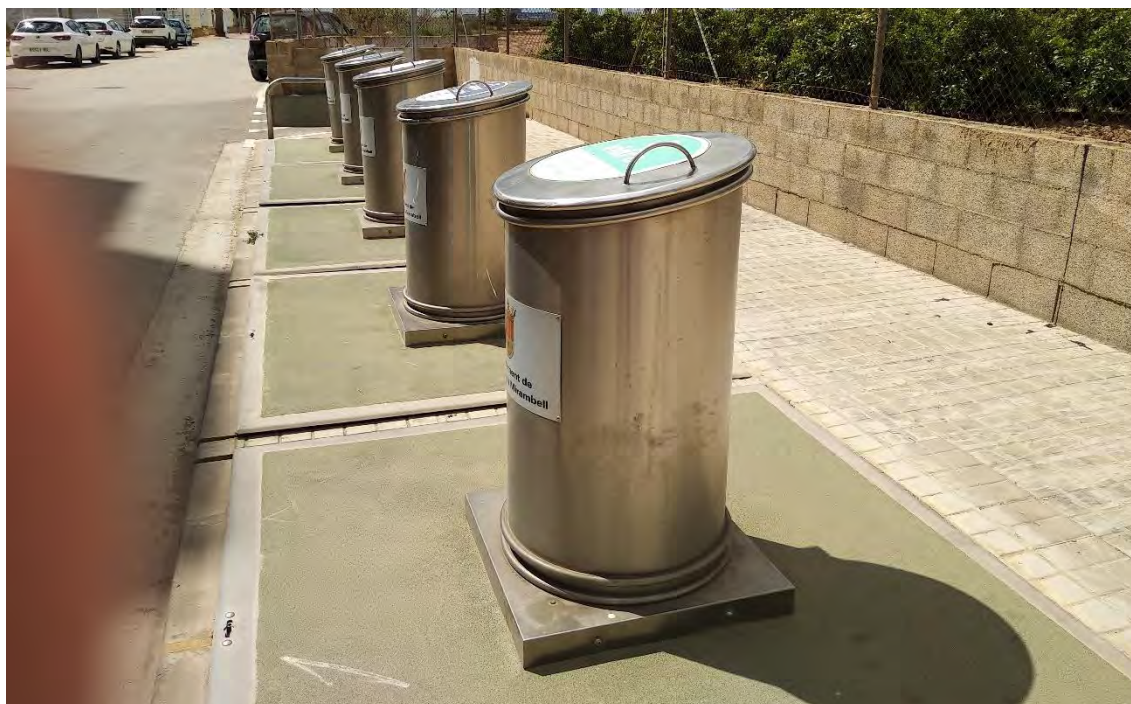
C/ Verge del Pilar, 43. La ubicación y orientación de los buzones del contenedor no permite el acceso desde el itinerario accesible, especialmente para personas usuarias de sillas de ruedas.
