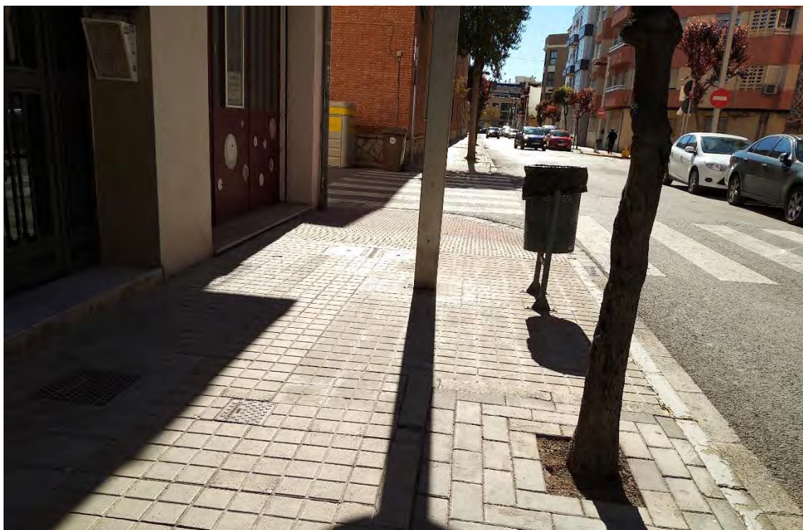
C/ Pintor Vicente Lluch. Inadecuada ubicación de farolas.
