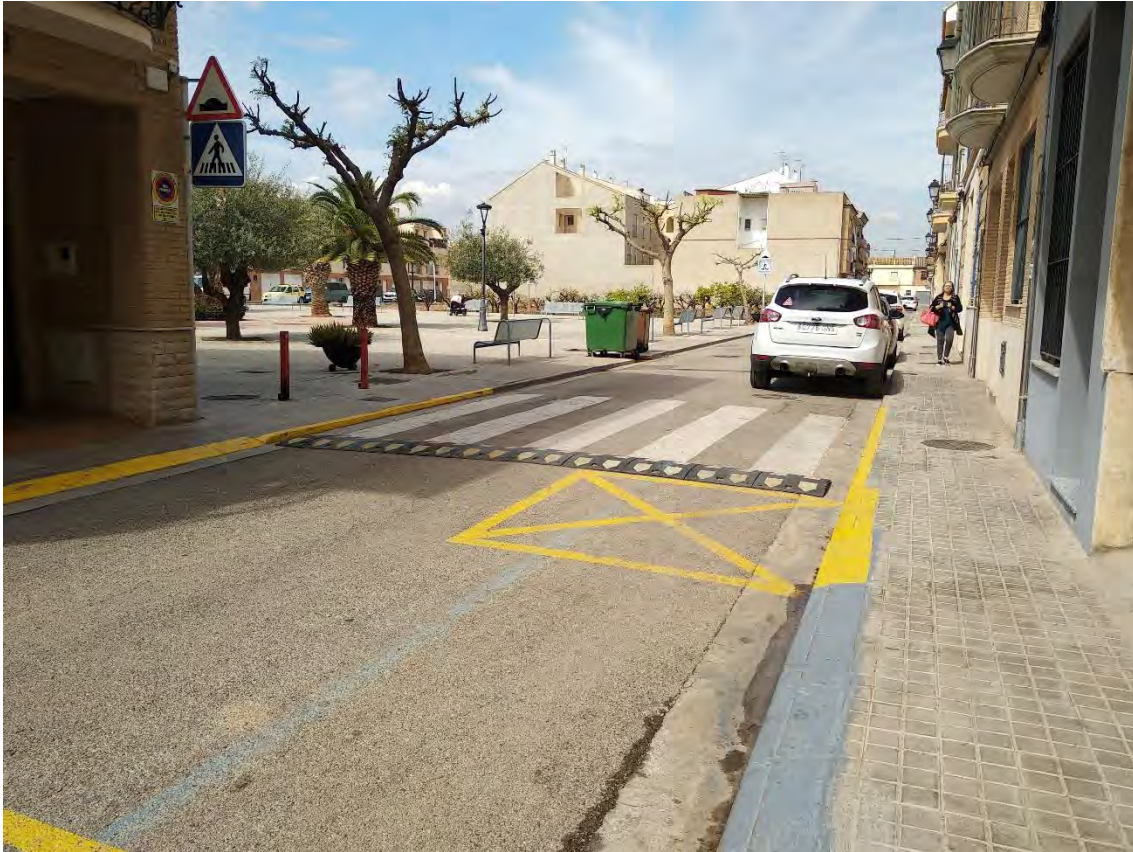
C/ Del Mig. Paso de peatones sin vado peatonal y con banda reductora de velocidad.
