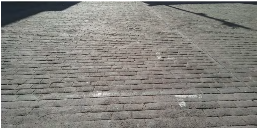
Plaça del Poble. Pavimento de hormigón impreso.
