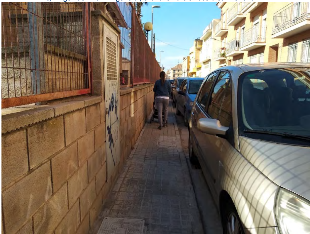
C/ Macarella, 43. Anchura de acera insuficiente para el cruce de dos peatones.
