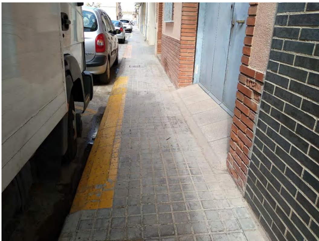
C/ Del Mig. La pendiente transversal de la acera no se altera ni se reduce su anchura.
