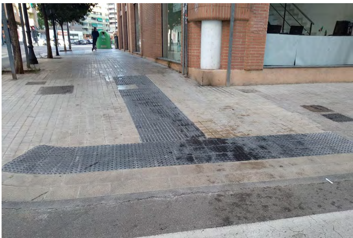
Ejemplo de uso correcto de pavimento táctil direccional y de advertencia en un vado peatonal (València).
