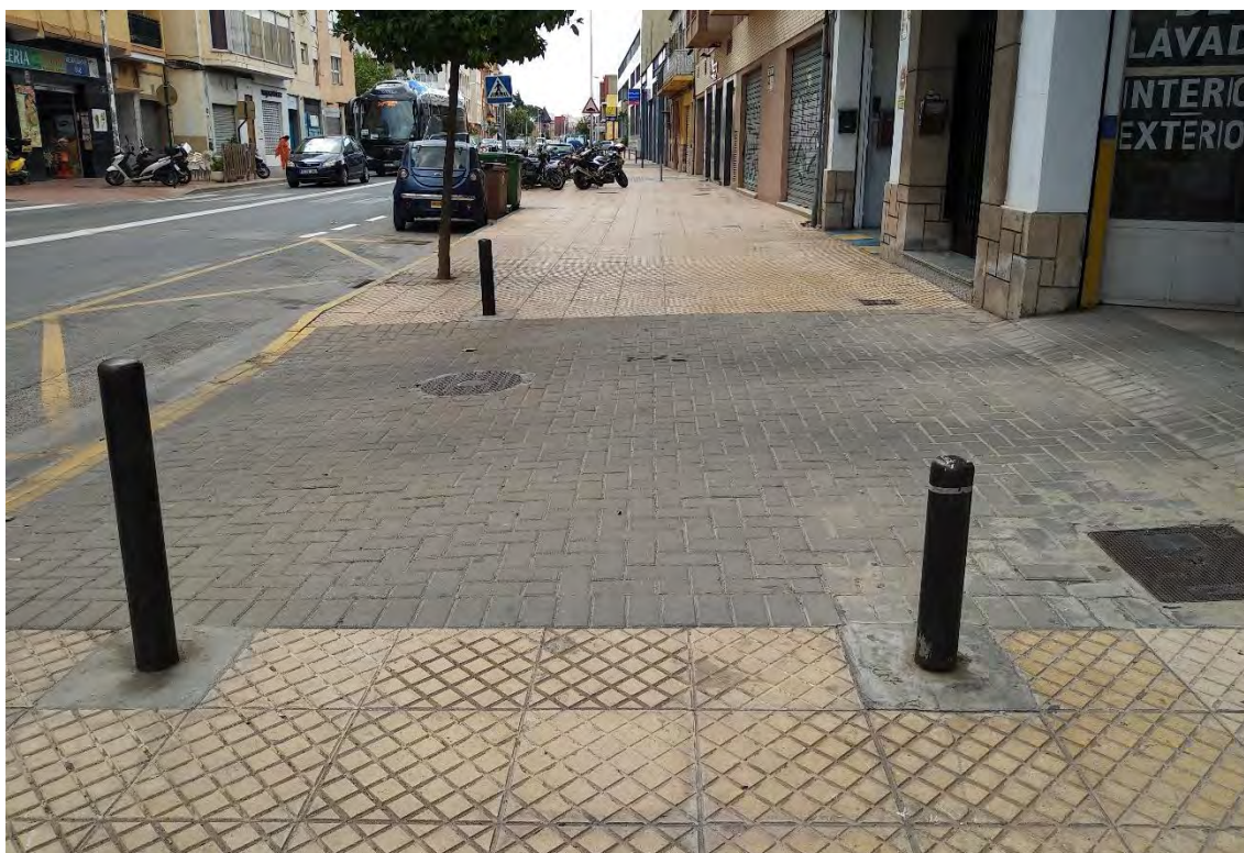
Antigua carretera de Barcelona. El bolardo de la izquierda tiene dimensiones adecuadas. El de la derecha, no.
