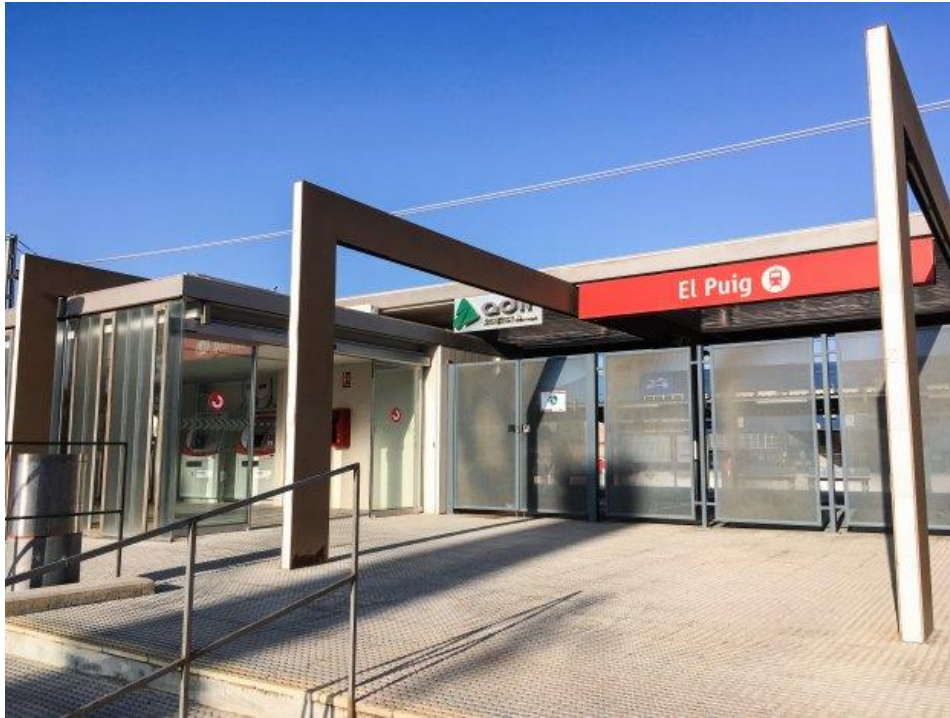
Imagen 4. Estación de tren El Puig
