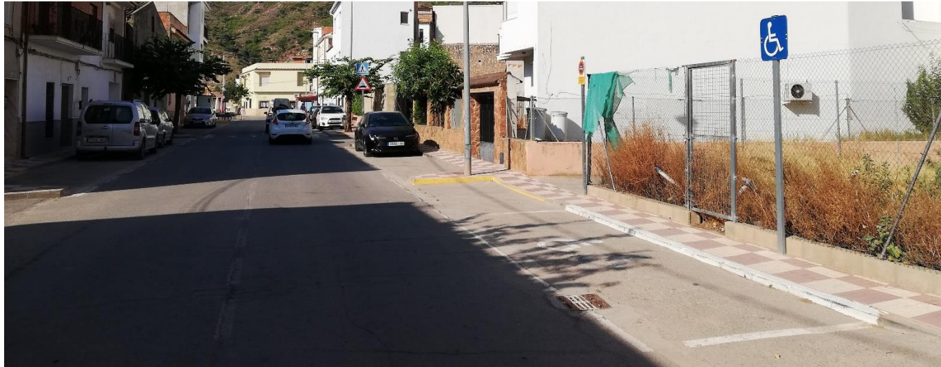
Ilustración 21. Detalle de una de las plazas de aparcamiento reservadas a personas con movilidad reducida en Avenida Diputación. Fuente: Elaboración propia.
