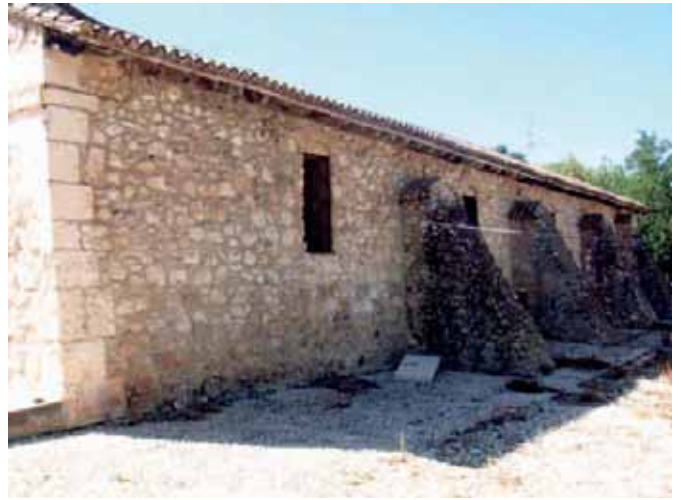
Contraforts del depòsit de sal
