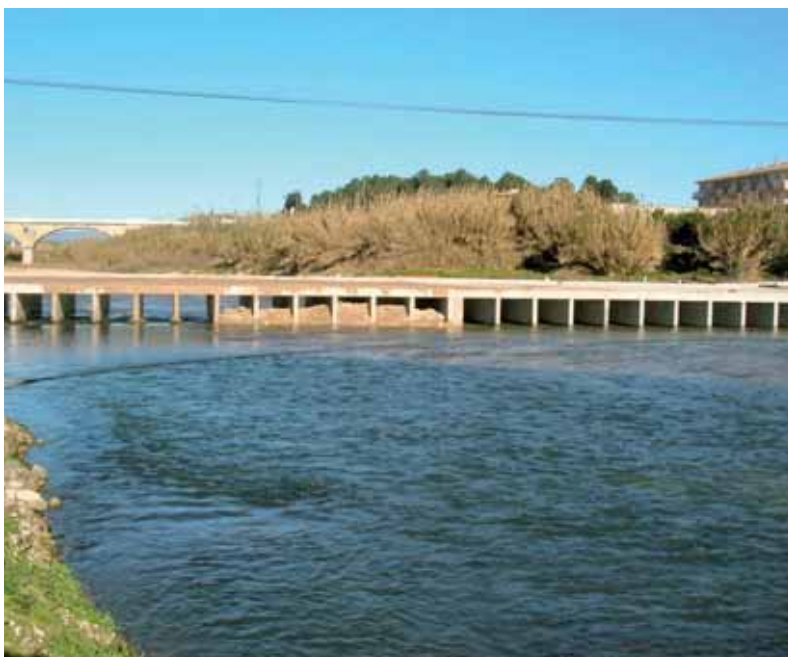
Pas de les Salines: gual en construcció l'any 2009
