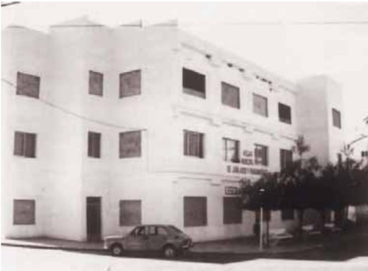
Façana de l'antic edifici i guarderia infantil, any 1983, essent Alcalde Paco Grau
