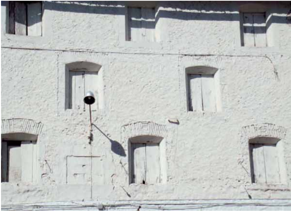
Sistema de ventilació de les cambres, per a regular la temperatura interior i criar cucs de seda, en andanes de canyís
