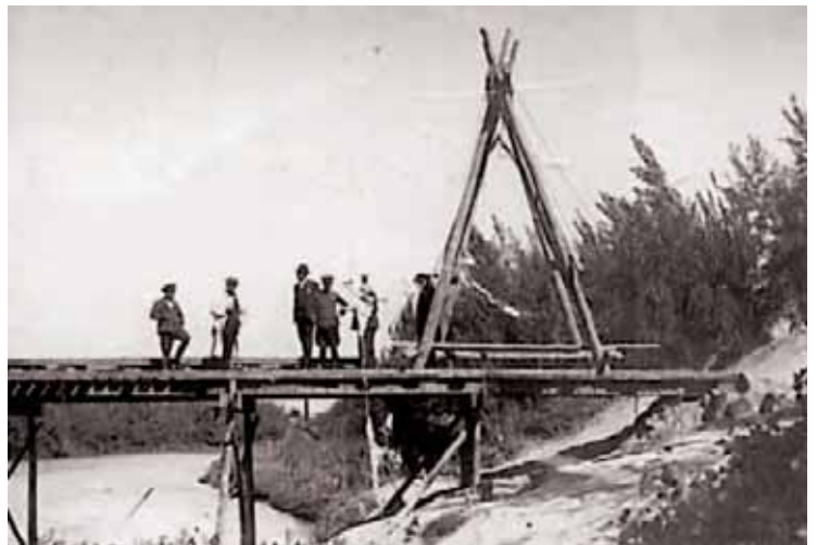
Construcció del pont dels Soldats, per a passar de Manuel al campament de les Salines (1925)
