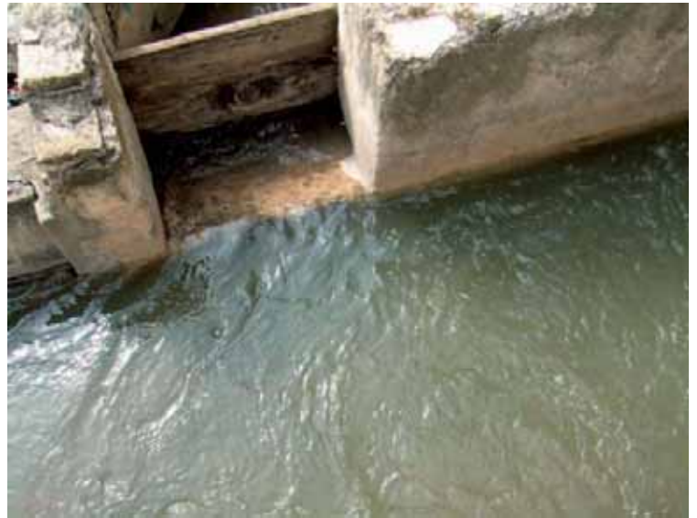
Un estellador amb la post posada
