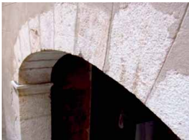
Detall de la Casa Gran de Torreta
