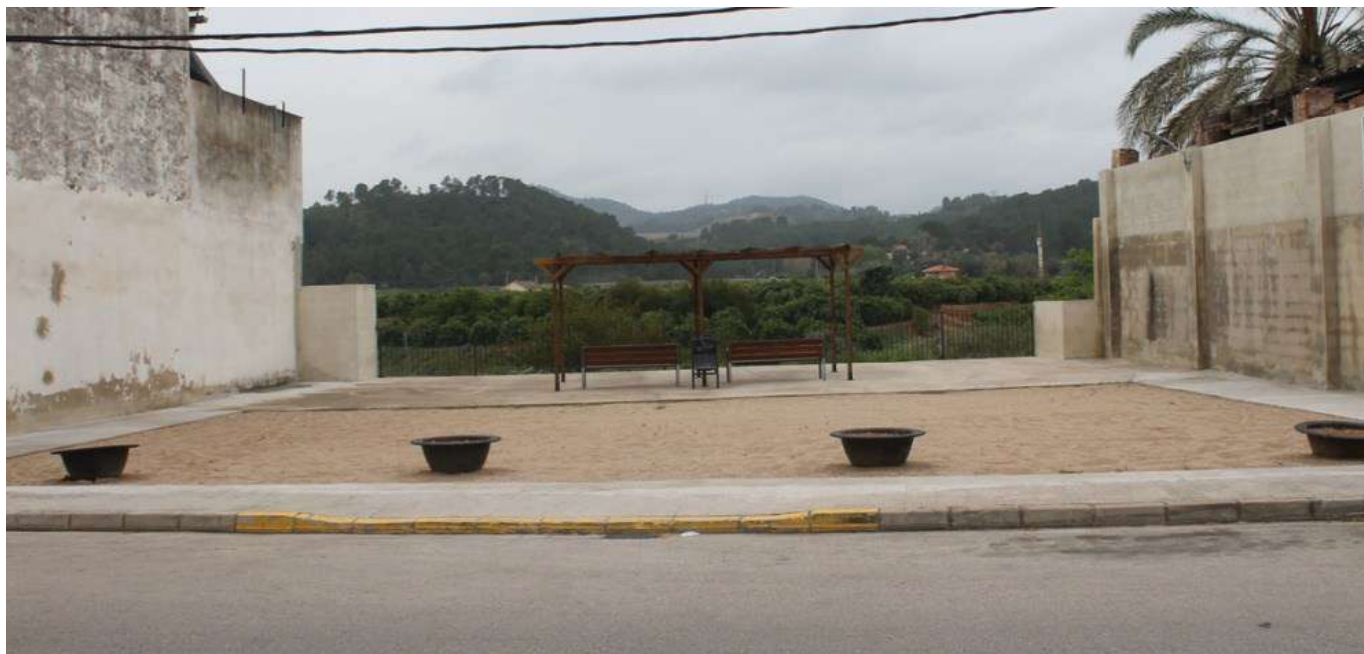
Actual estat després de l'actuació
