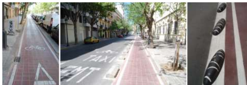
Detalle de carriles bici segregados
