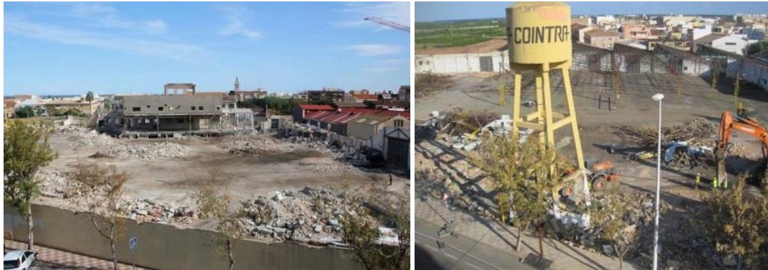
Figura 10. Imágenes de la demolición de la factoría Cointra.
