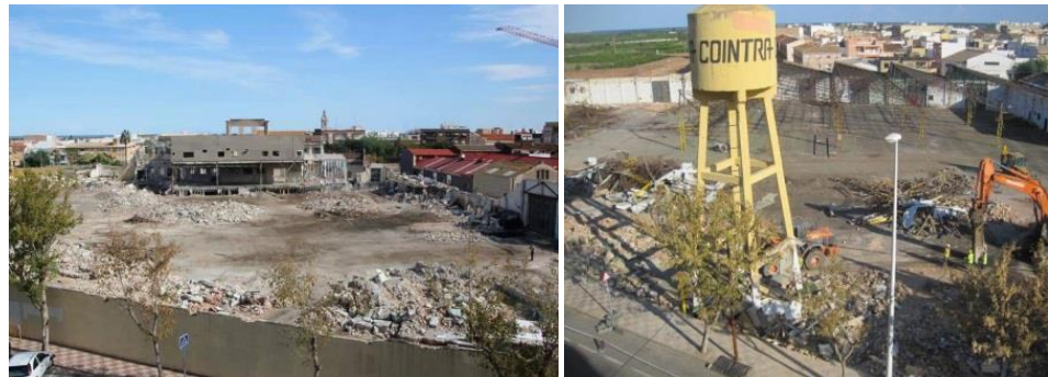
Figura 9. Imágenes de la demolición de la factoría Cointra.
