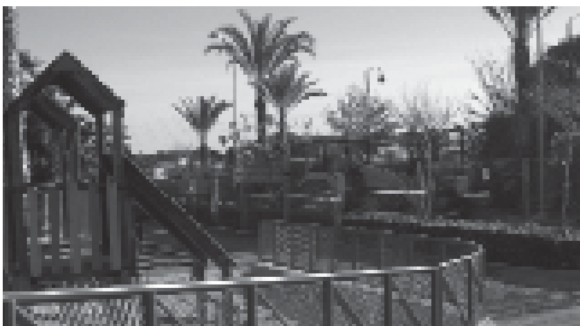
Obras en el Parque Polideportivo.
