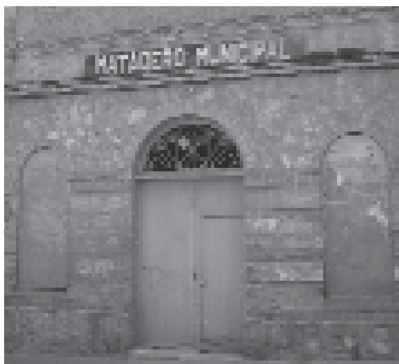
Edificio del antiguo Matadero Municipal.
