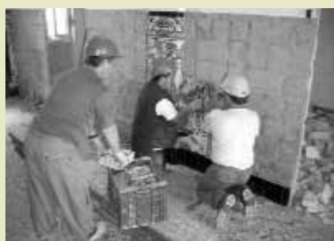
Empresa constructora desmuntant el xapat.
