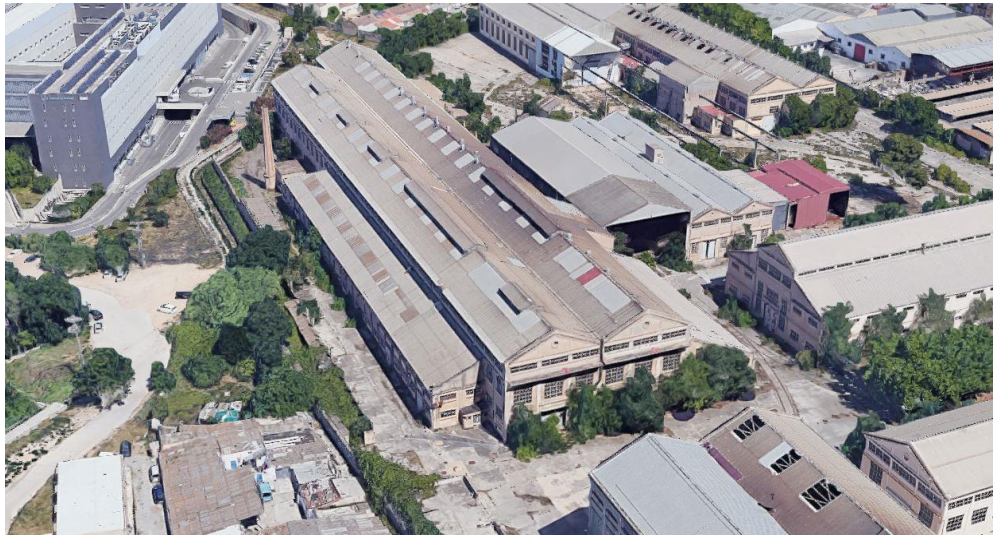
Fotografía con vista de la envolvente del conjunto naves industriales 03
