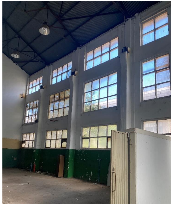
Imagen del interior del conjunto y fachadas interiores
