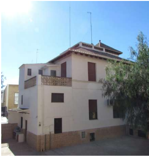
4. Vista general de la fachada
