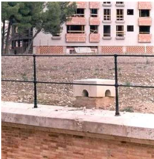
6. Vista de la cubierta del depósito
