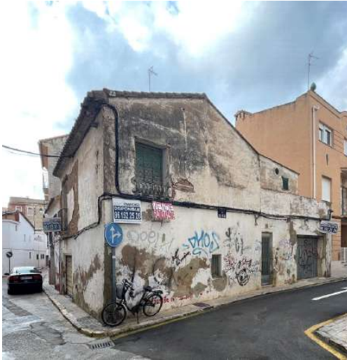
4. Vista general de las fachadas
