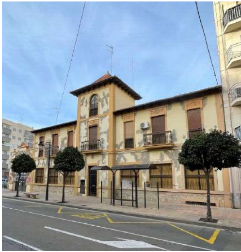
4. Vista general de la fachada
