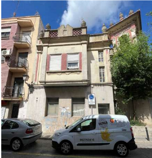
4. Fachada recayente a la C/ de l'Estació
