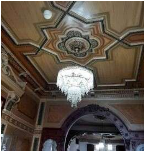
4. Vista de los techos
