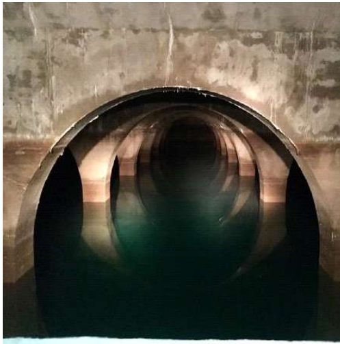
4. Vista del interior del depósito
