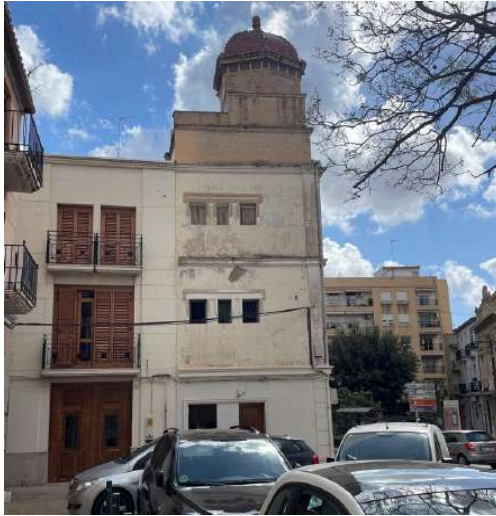
4. Vista de la fachada recayente a la Pl. Valdecabres
