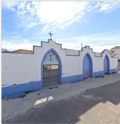
4. Vista general de la fachada
