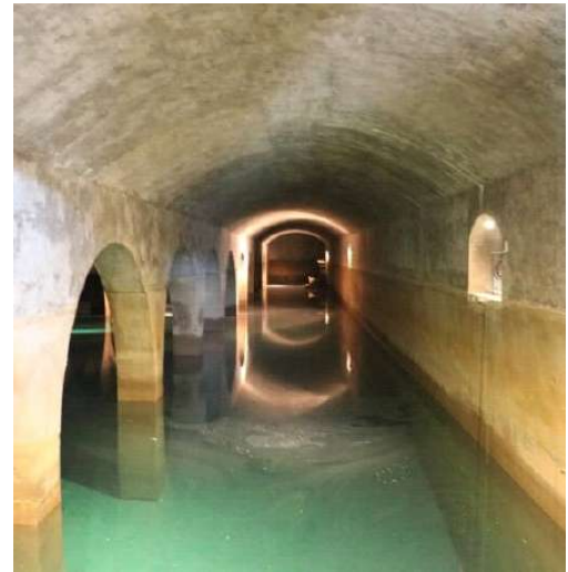
5. Vista del interior del depósito
