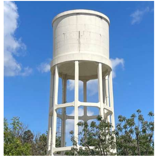
5. Vista de la parte superior del depósito
