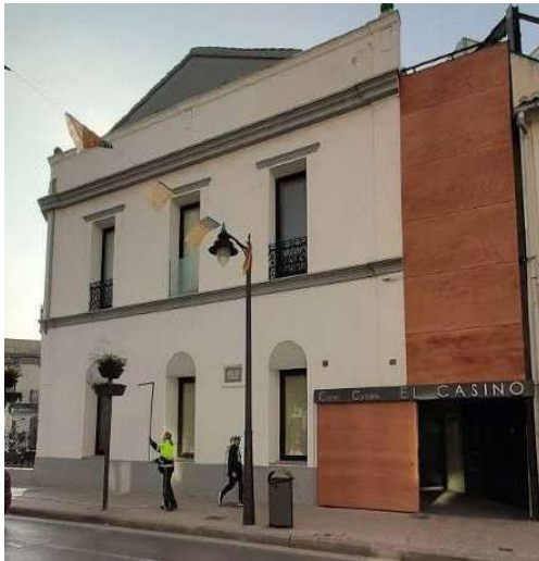
4. Vista de la fachada recayente a la C/ Joanot Martorell
