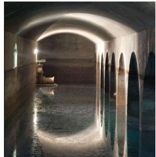
7. Vista del interior del depósito
