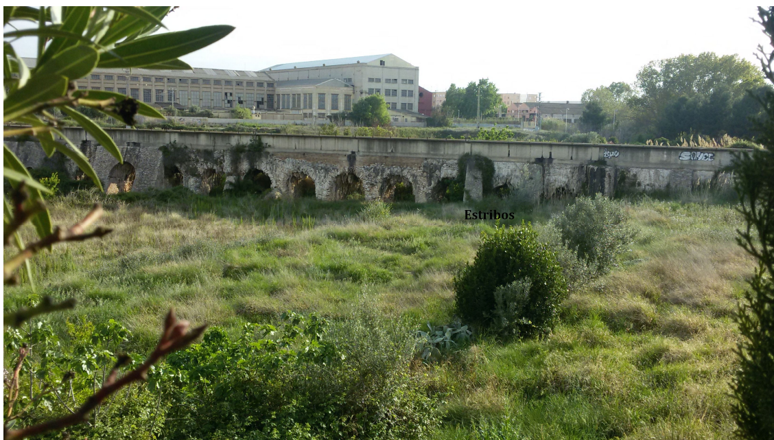
Fig. 14. Estado actual del acueducto y de los estribos fabricados por Dauder
