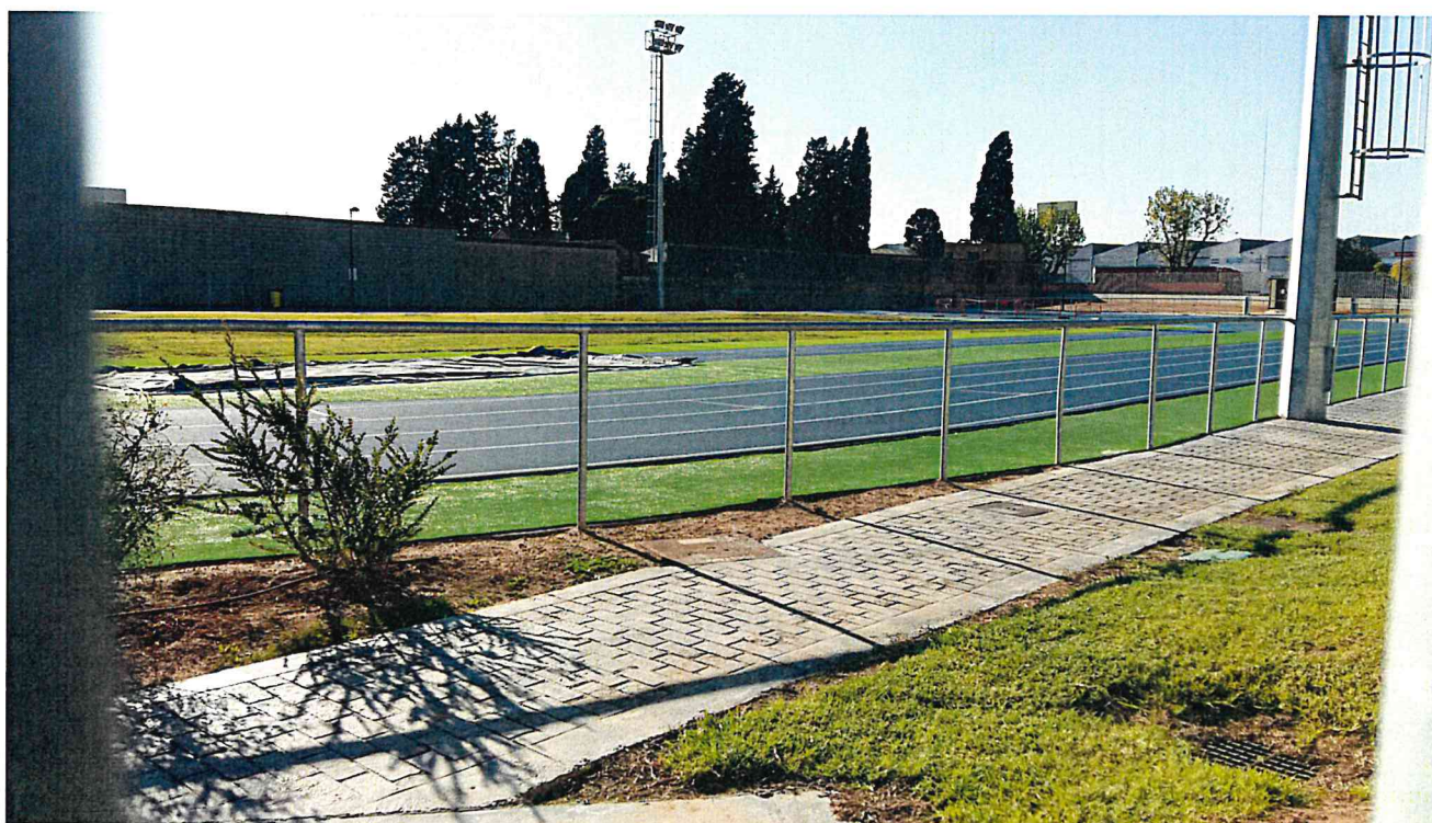
Vista del interior del equipamiento. Pistas Polideportivas.
