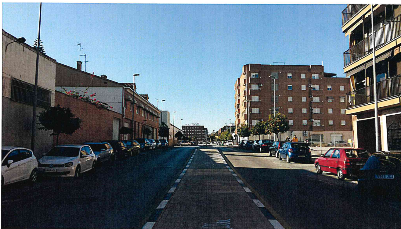
Calle Trece Rosas. Alguna fachada de zona industrial busca soluciones arquitectónicas de mimetización con la arquitectura residencial.
