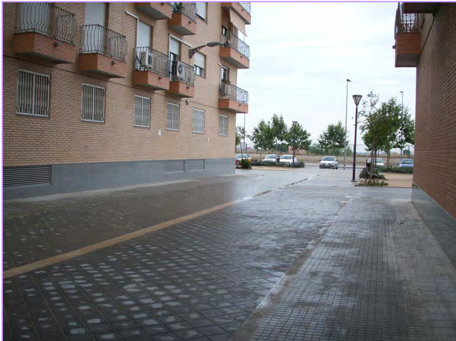
9. Foto: Accés per a vianants a la plaça. Autora: Ma Amparo Martínez Milvaques.
