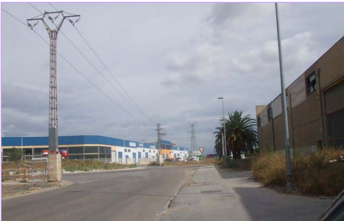
10. Foto: Torre d'alta tensió. Autora: Ma Amparo Martínez Milvaques.
