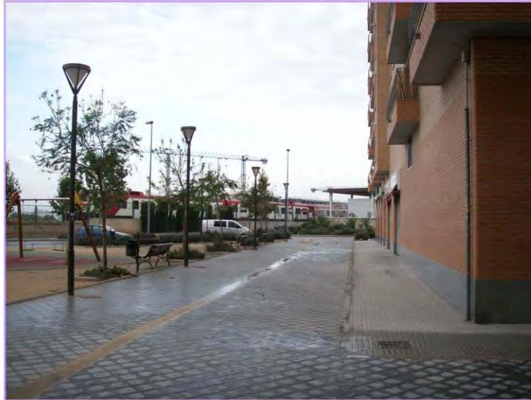
14. Foto: Infraestructura. Autora: Ma Amparo Martínez Milvaques.
