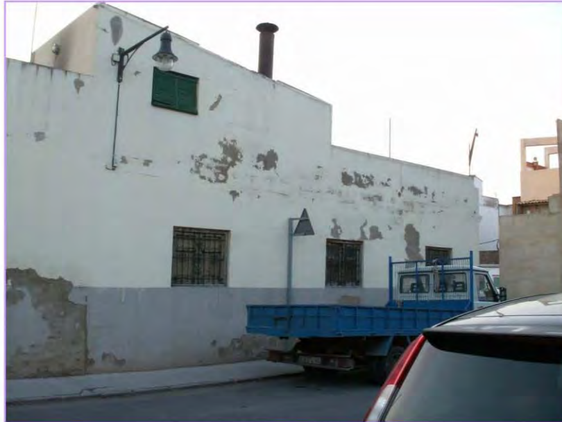
5. Foto: Edifici. Autora: Ma Amparo Martínez Milvaques.
