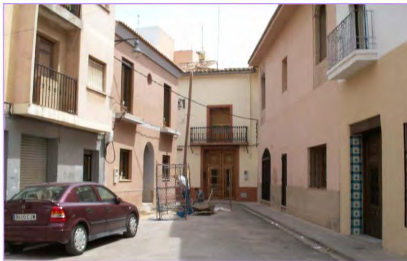
4. Foto: Edifici. Autora: Ma Amparo Martínez Milvaques.
