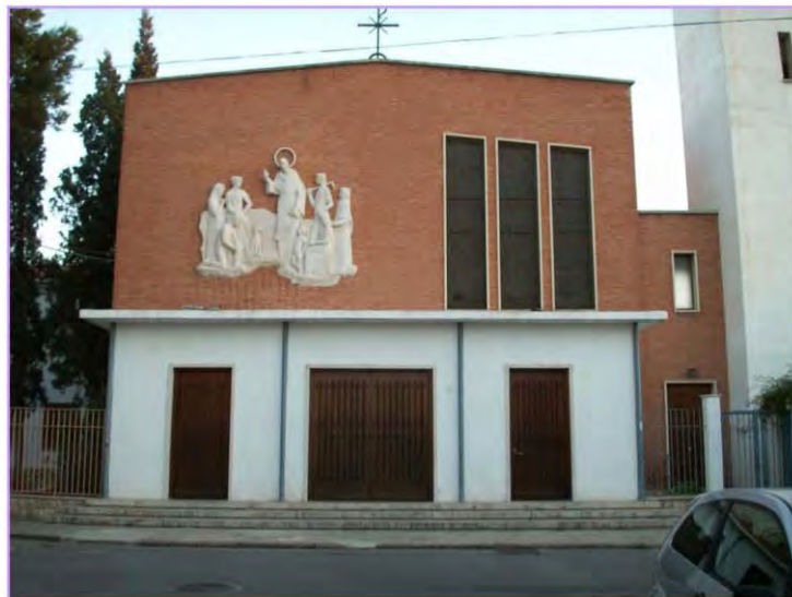
14. Foto: Edifici. Autora: Ma Amparo Martínez Milvaques.
