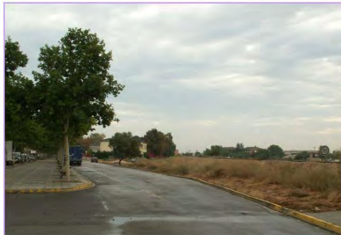
10. Foto: Infraestructura. Autora: Ma Amparo Martínez Milvaques.
