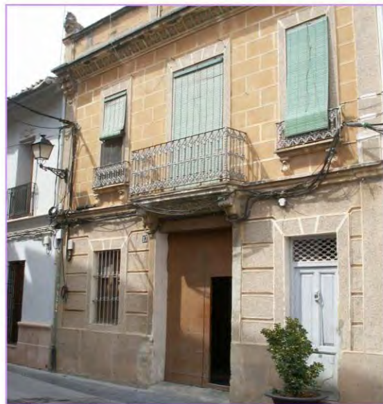
13. Foto: Edifici. Autora: Ma Amparo Martínez Milvaques.
