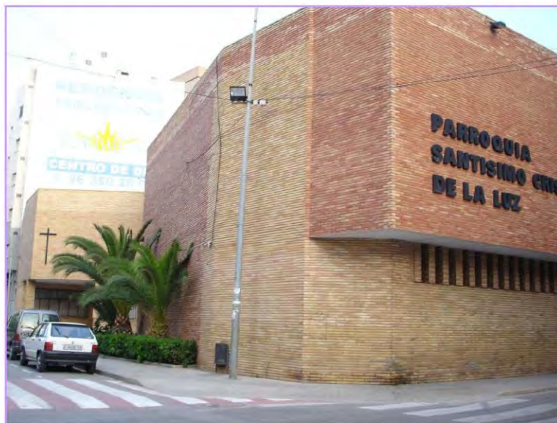
13. Foto: Edifici. Autora: Ma Amparo Martínez Milvaques.
