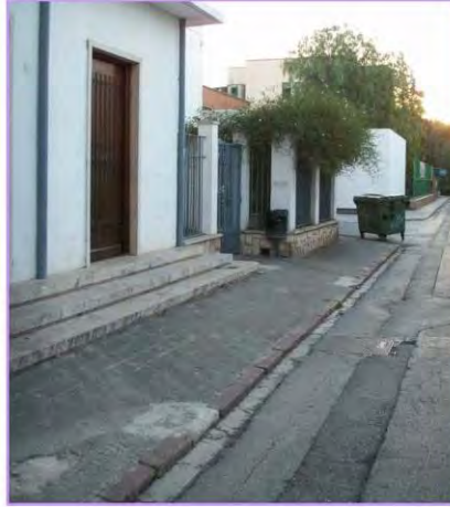
13. Foto: Paviment i voreres. Autora: Ma Amparo Martínez Milvaques.
