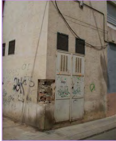
5. Foto: Edifici. Autora: Ma Amparo Martínez Milvaques.
