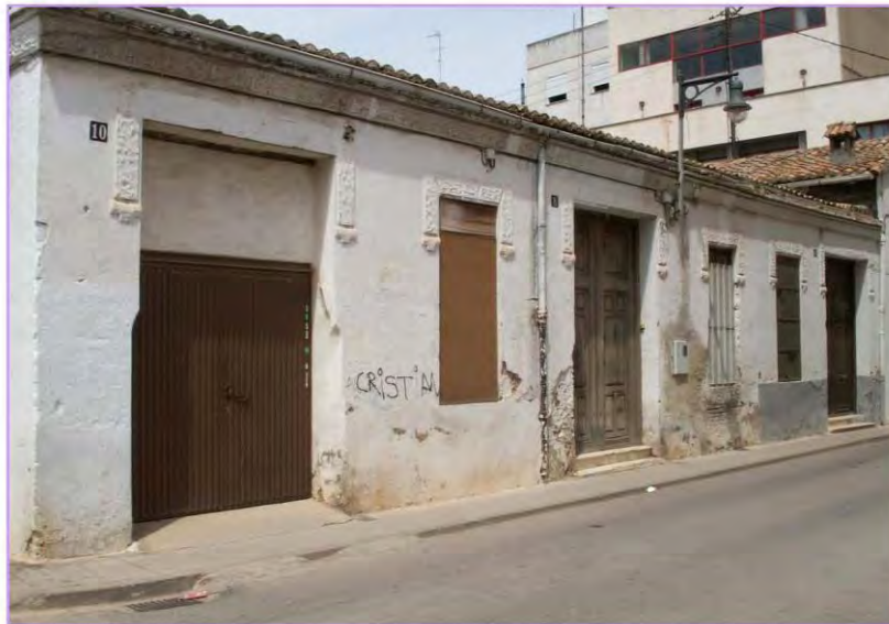
6. Foto: Edifici. Autora: Ma Amparo Martínez Milvaques.
