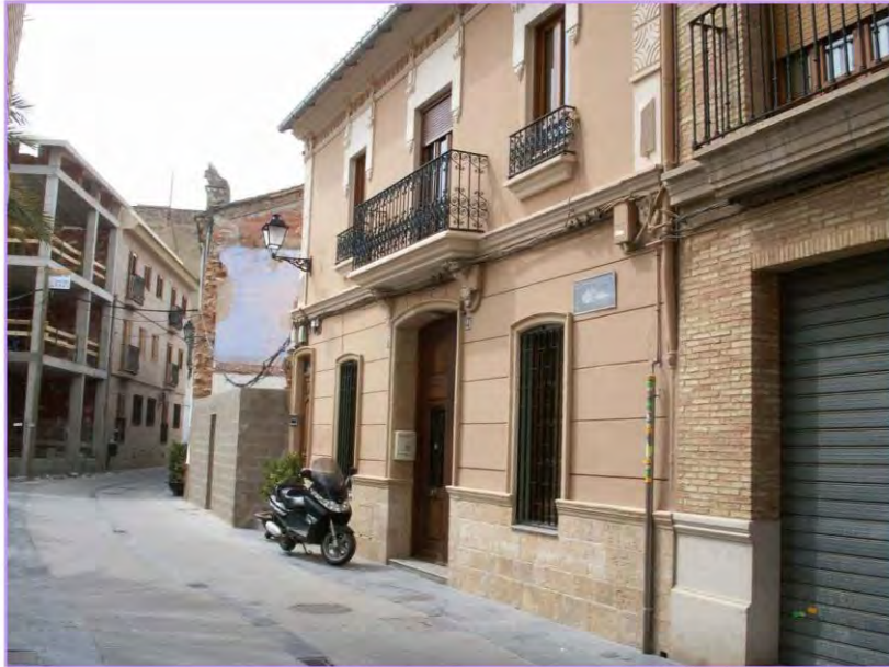
14. Foto: Edifici. Autora: Ma Amparo Martínez Milvaques.
