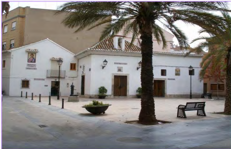
15. Foto: Edifici. Autora: Ma Amparo Martínez Milvaques.
